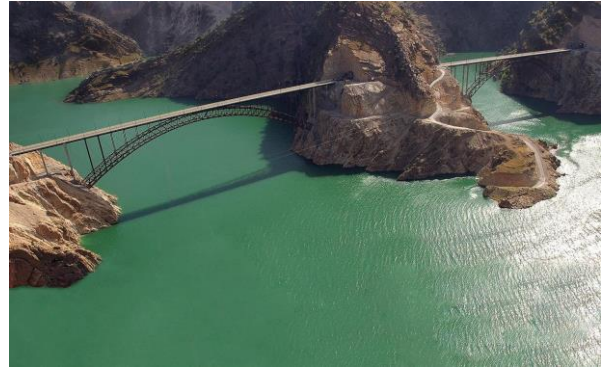
Pontes em arcos treliçados sobre o rio Karun, Irã (2012) vão principal (300m)
