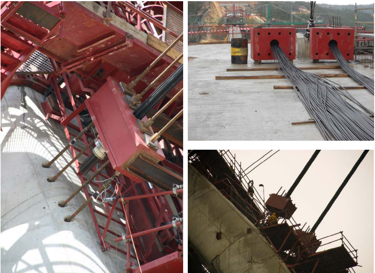
Figura 18. Anclajes pasivos tirantes principales y secundarios
