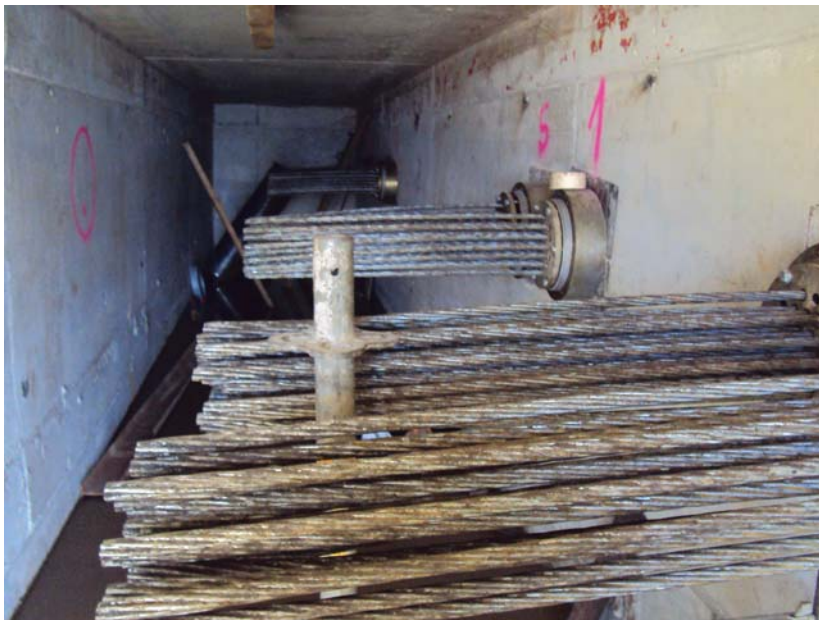
Figura 10. Tendones de cosido del tablero al estribo norte punto fijo de servicio.
