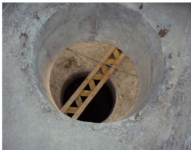
Figura 11. Apoyo POT frontal entre estribo y tablero y detalle de visita de apoyos sobre pilas.
