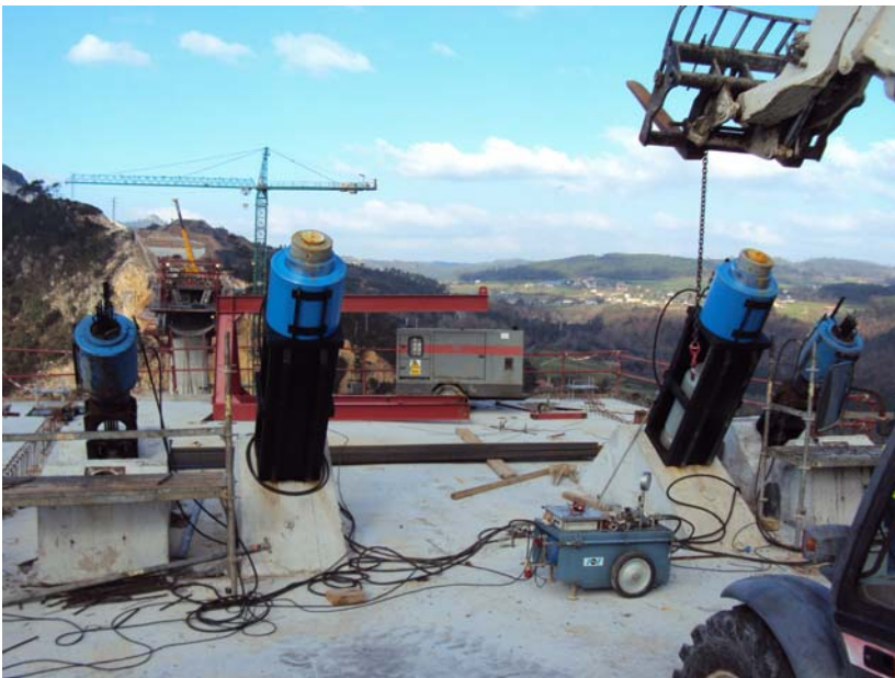
Figura 17. Tesado en anclajes activos
