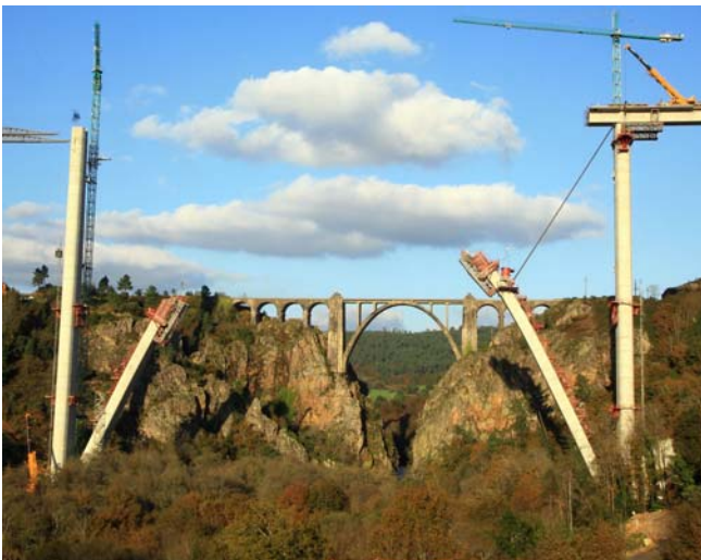
Figura 13. Alzado en construcción
