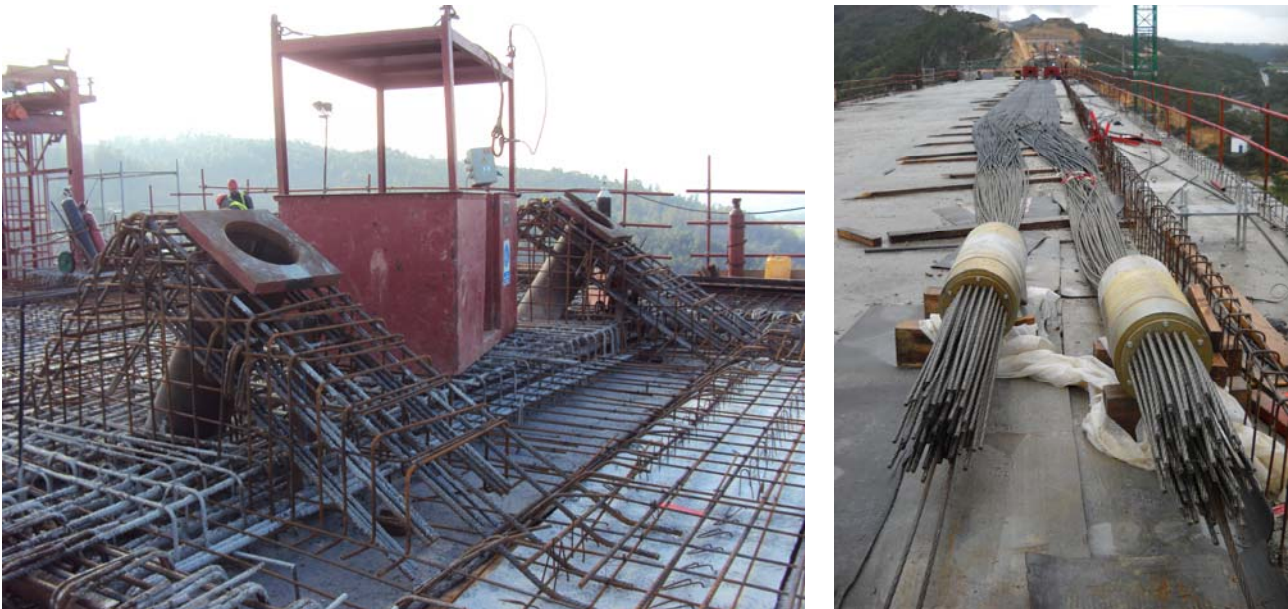
Figura 16. Preparación de tirantes
