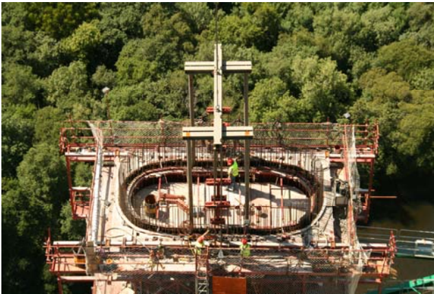
Figura 4. Ejecución fustes de pilas.
