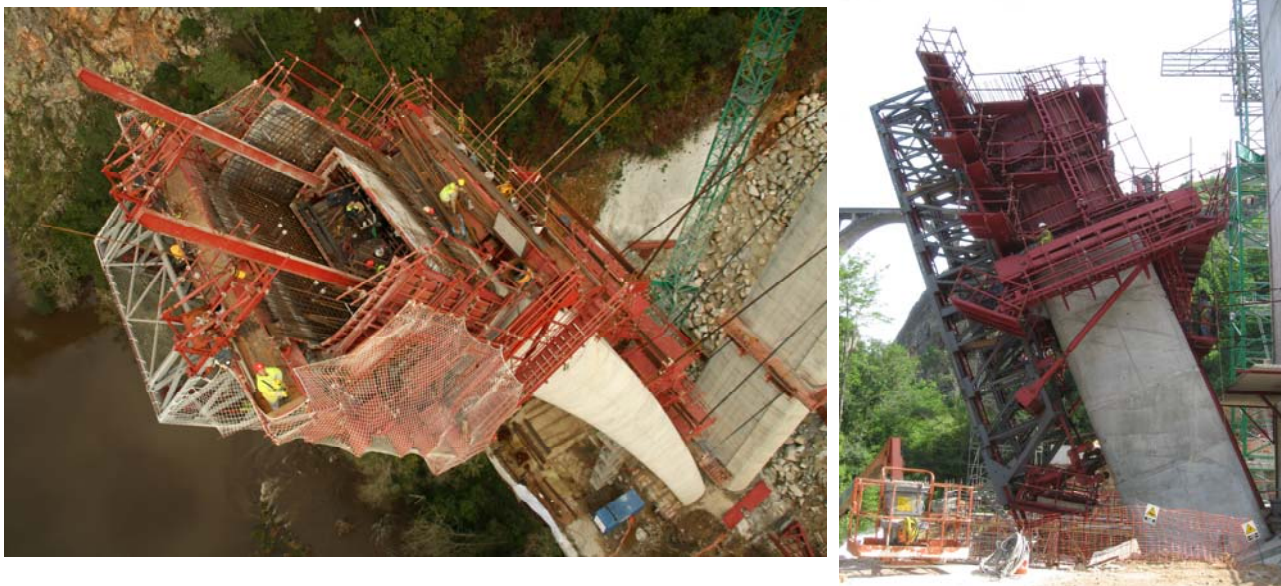
Figura 14. Carro de dovelas
