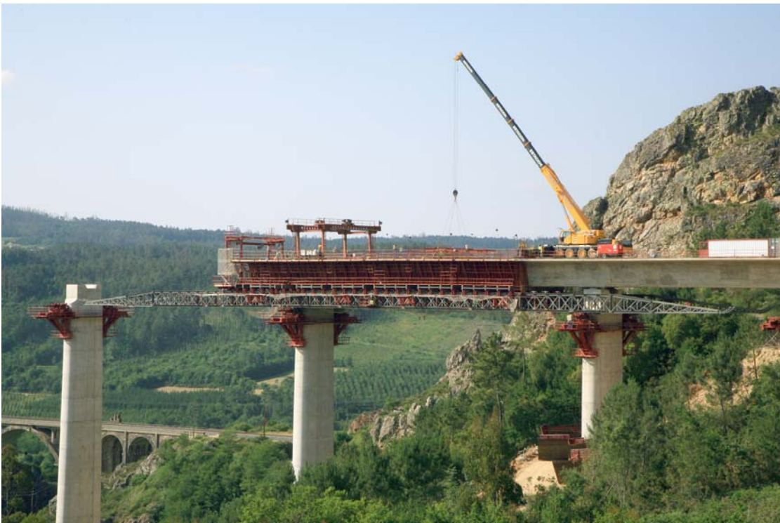
Figura 7. Cimbra autolanzable en tramo de acceso.
