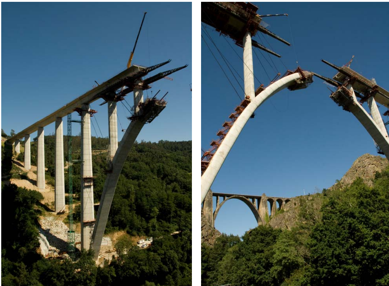
Figura 20. Situaciones en construcción
