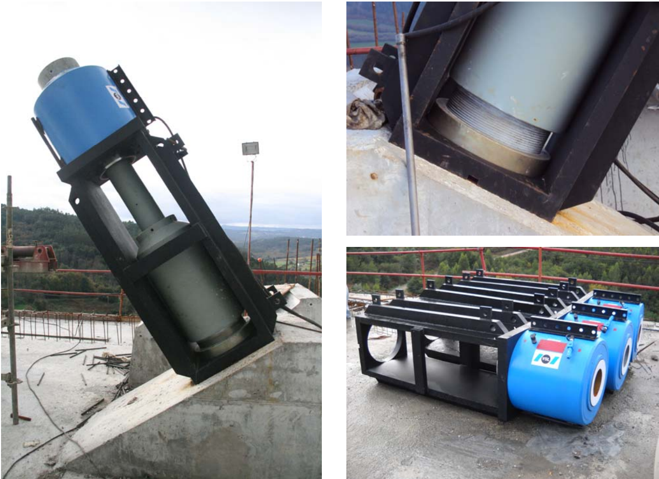
Figura 21. Anclajes activos de tirantes principales
