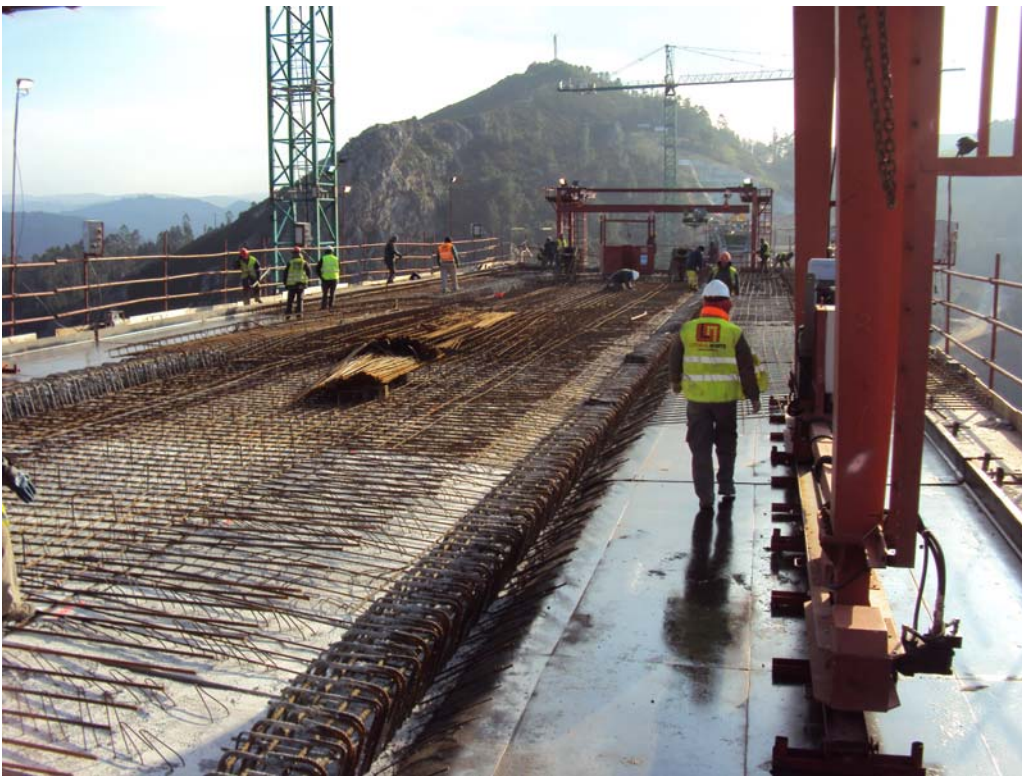
Figura 9. Ejecución segunda fase del tablero.
