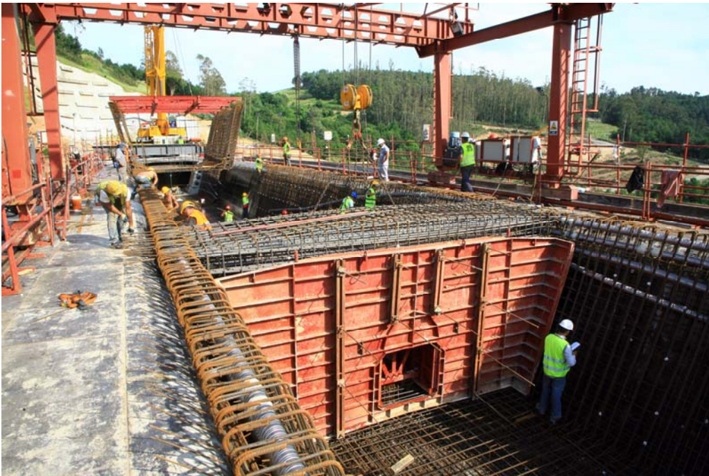
Figura 8. Ejecución primera fase del tablero.
