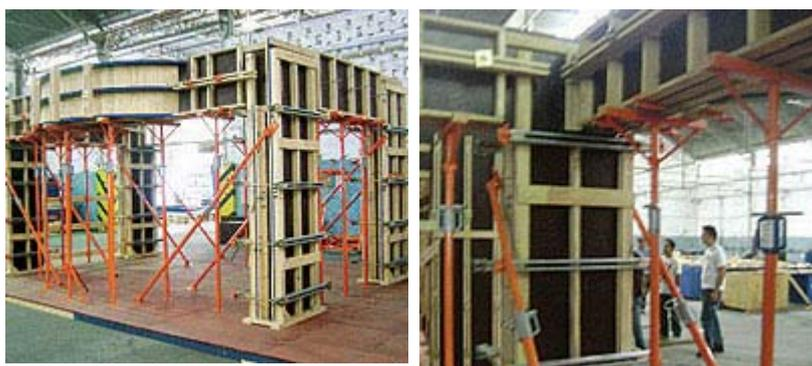
Fotos 11 e 12 - Montagem do conjunto com cimbramento metálico
