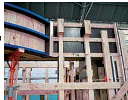
Foto 4 - Fundo de vigas e lajes limitam o uso dos garfos de madeira
