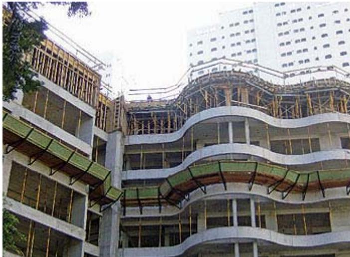
Foto 1 - Estrutura executada com sistema de fôrma pré-fabricada em madeira
