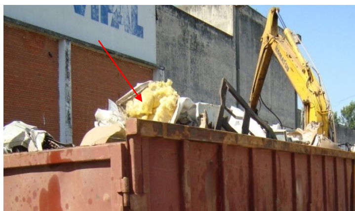
Figura 17 – Transporte de sucata de REEE de refrigeração contendo espuma de poliuretano impregnada com CFC.
