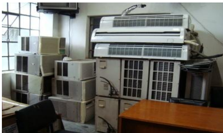
Figura 4 – Depósito protegido de equipamentos de ar condicionado, baixados do patrimônio de unidade no Campus QS/D
