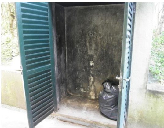
Figura 29 - Abrigo de resíduos comuns da UBS-A, fev./2011
