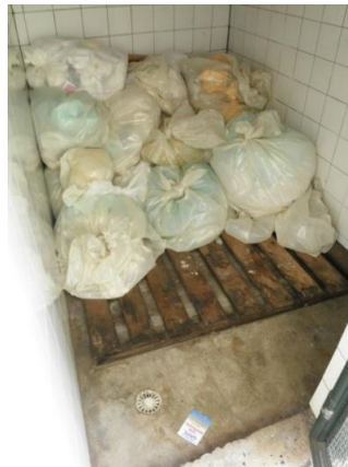
Figura 22 - Abrigo de resíduos infectantes da UBS-B, fev./2011
