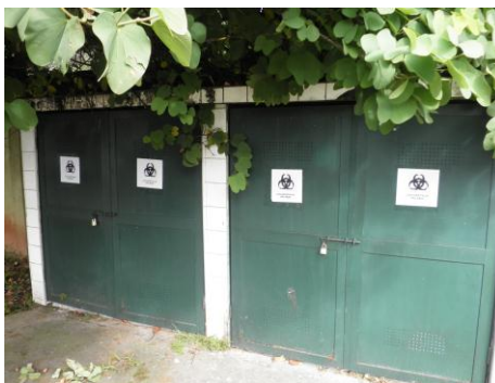
Figura 1 - Abrigos externos de resíduos químicos e infectantes, UBS-A, fev./2011
