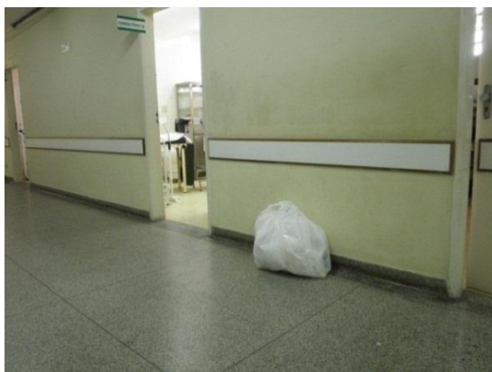
Figura 17 – Saco branco sem identificação, contendo infectantes, estacionado sobre o piso no corredor da UBS-A, fev./2011
