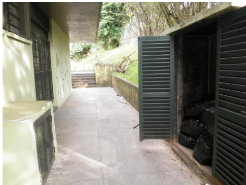
Figura 2 - Abrigo para resíduos comuns, UBS-A, fev./2011
