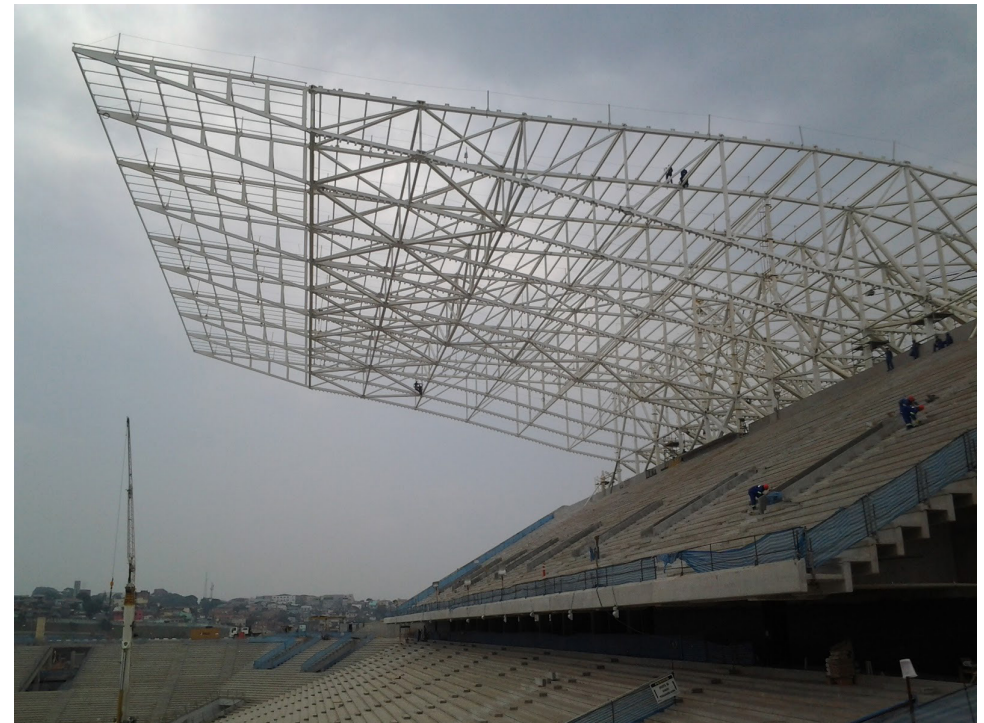
Foto da estrutura da cobertura
