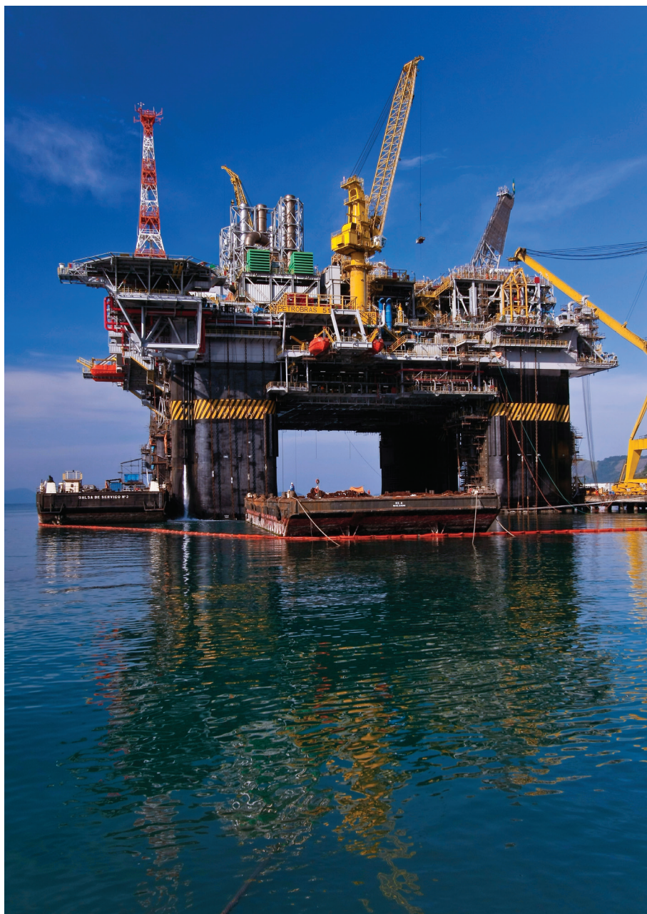
Figura 12 Plataforma semissubmersível P-51 no estaleiro
