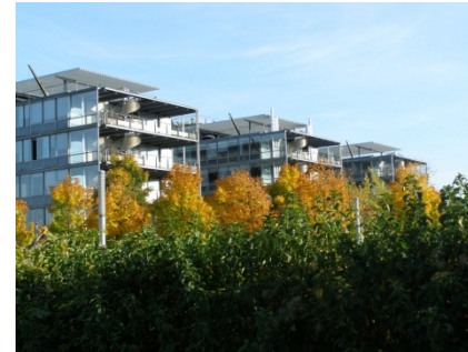
Ecole Nationale des Ponts et Chaussées - Paris
