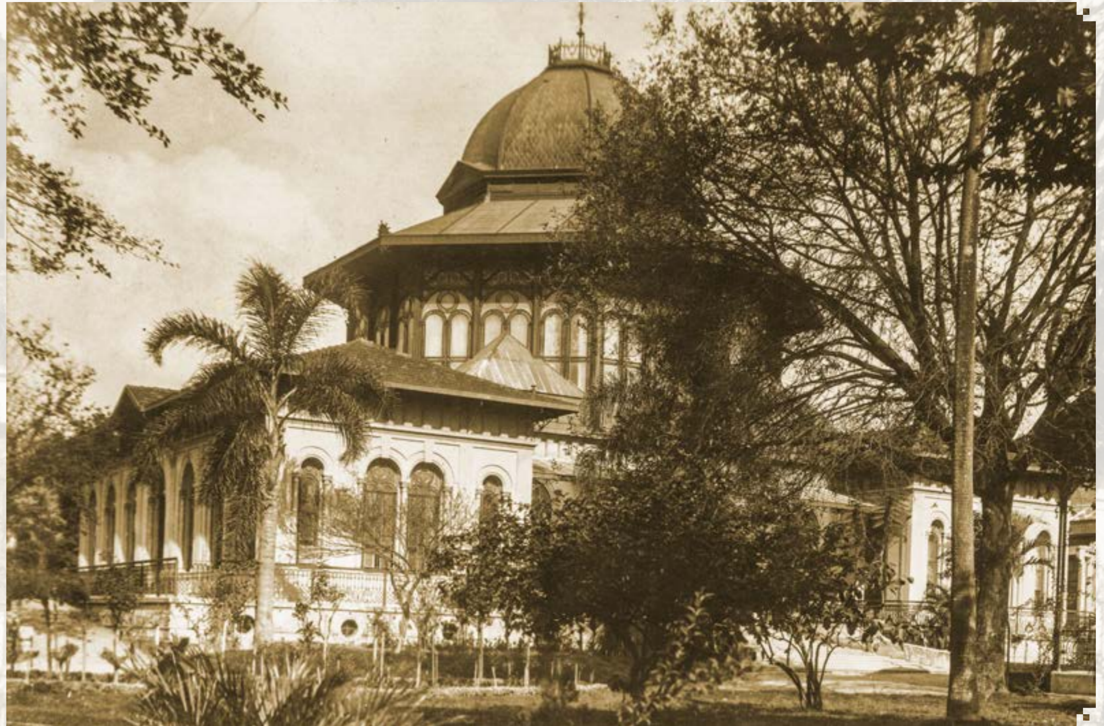
Edifício do Jardim de Infância da Caetano de Campos
