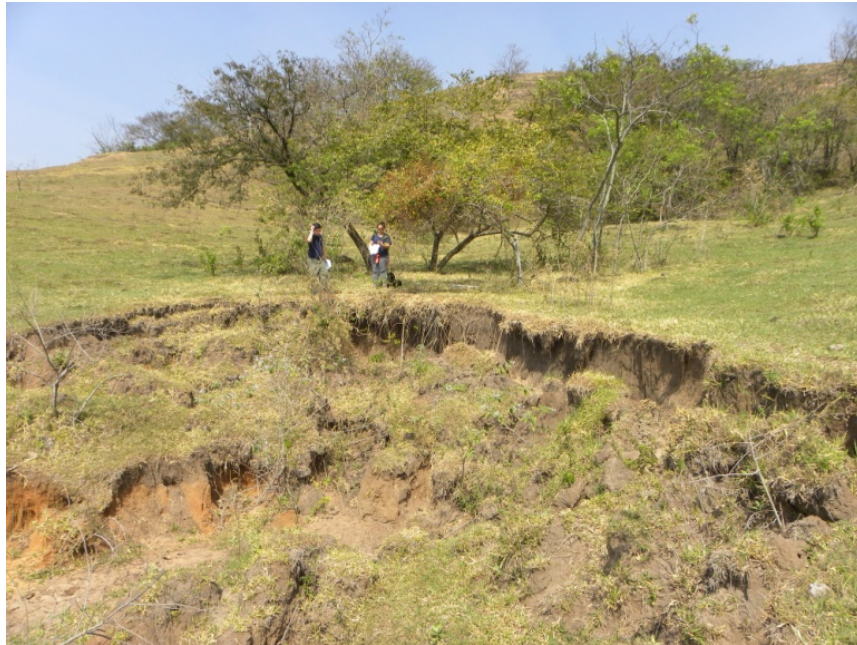
Figura 33: Cabeceira de voçoroca de encosta circular ativa (classe IIa).
