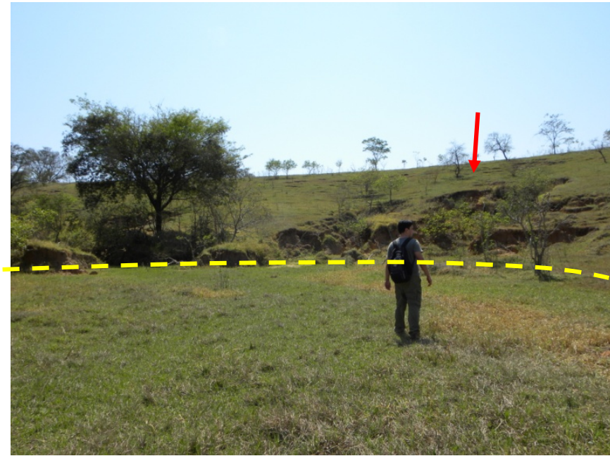
Figura 32: Exemplo de ruptura côncava (linha amarela tracejada) onde normalmente se iniciam as voçorocas de encosta. A seta vermelha indica uma voçoroca de encosta circular.
