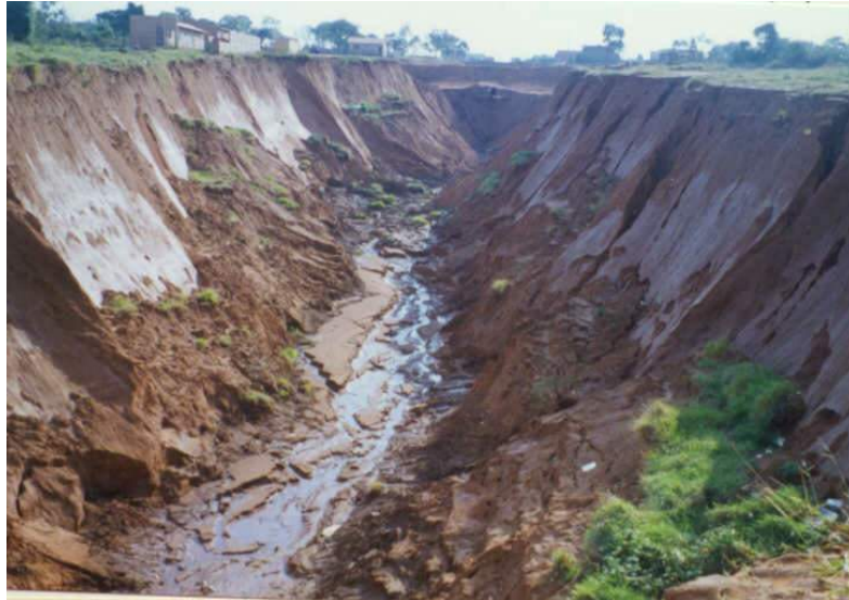
Figura 4: Voçoroca próxima à área urbana de Bauru (SP). Notar os depósitos de sedimentos no sopé dos taludes laterais indicando a ocorrência de movimentos de massa. Fonte: Instituto de Pesquisas Tecnológicas do Estado de São Paulo – IPT/SP.
