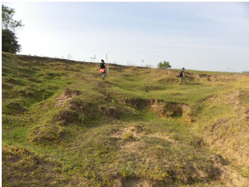
Figura 34: Cabeceira de voçoroca de encosta circular inativa (classe IIb).
