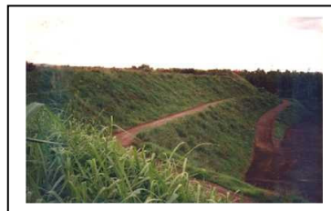
Figura 2.20: Mostra uma vista panorâmica tela ARP430, nos taludes da siderúrgica, em 15(a) e 77(b) dias respectivamente depois de implantada a tela.
