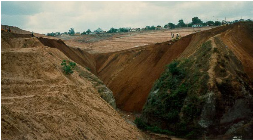
Figura 5.29: observa-se a construção do Terraceamento em nível (murundus) em 1992 (Pejon e Zuquette, 2001)
