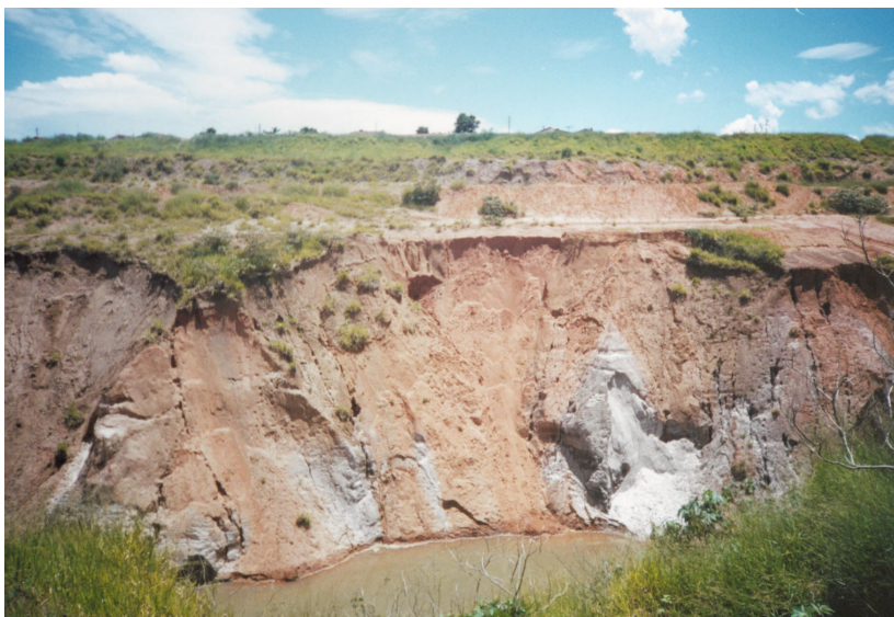
Figura 6.3- mostras a Voçoroca do São Dimas em intensa atividade em nov 2003, com escorregamento das encostas.
