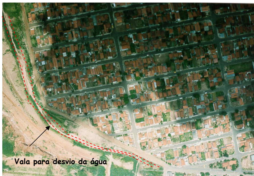
Figura 5.35- Mostra a vala utilizada para desviar o fluxo de águas pluviais do canal do Dimas em 2000.
