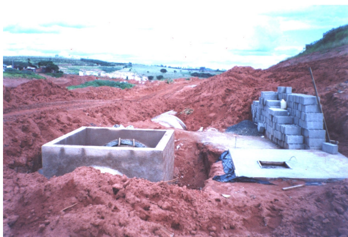
Figura 2.9: Execução de obras de disciplinarmente do fluxo para contenção de voçoroca de São Pedro/SP
