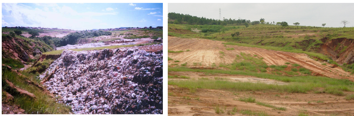
Figura 6.4- Voçoroca lixão em Jan/2003 antes de seu fechamento e depois de fechado e Aterrado.
