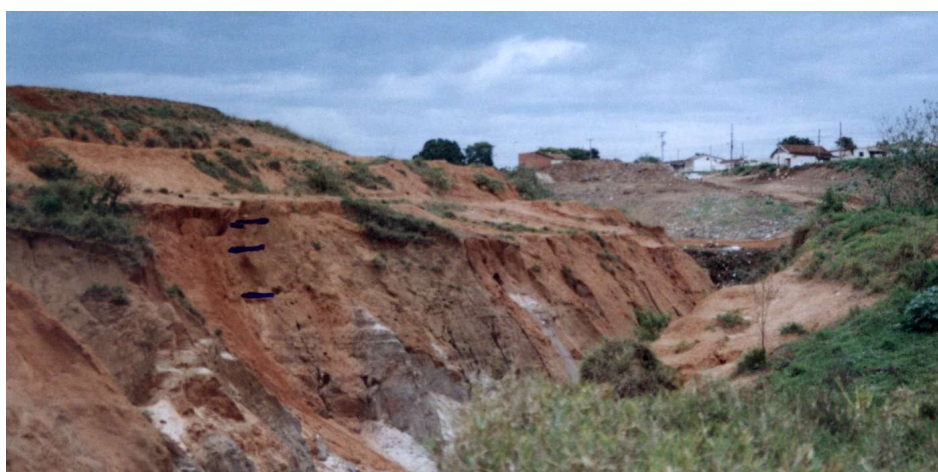
Figura 6.5- o início do canal do São Dimas, passou a ser utilizada como área de deposição de resíduos de construção civil e restos vegetais.
