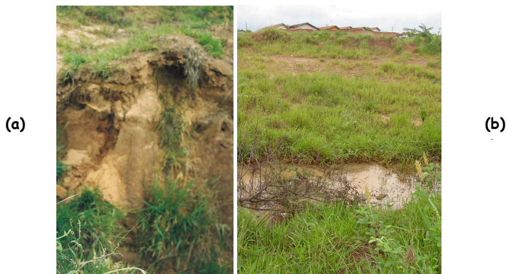
Figura 5.36- Observar os cordões rompidos (A) e acumulando água (B) no verão de 2004.
