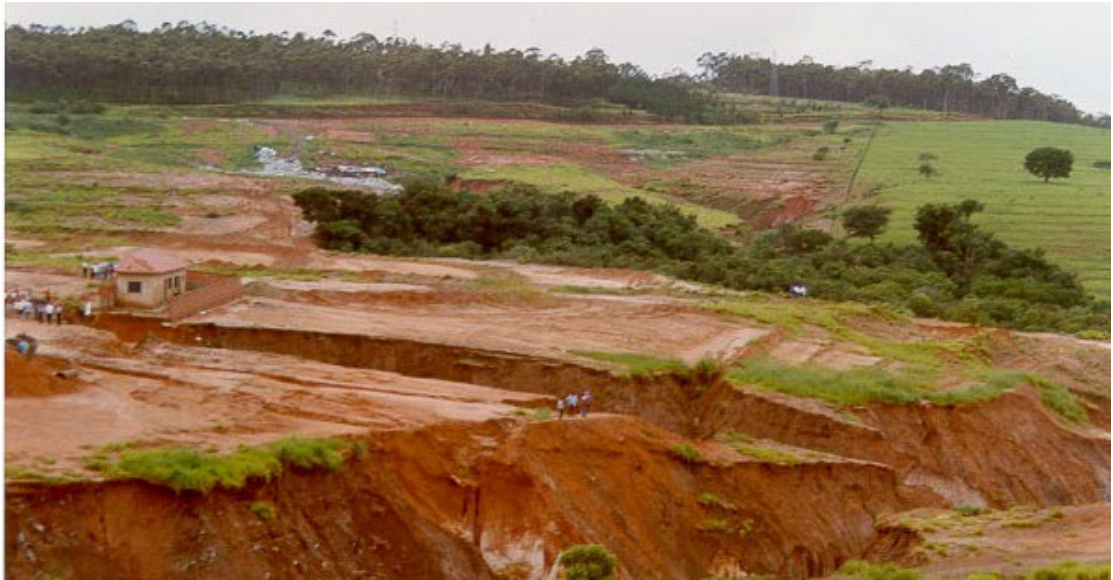
Figura 5.4- Casa afetada pela reativação da ravina aterradas na encosta do canal do Dimas. Em dezembro de 2000.
