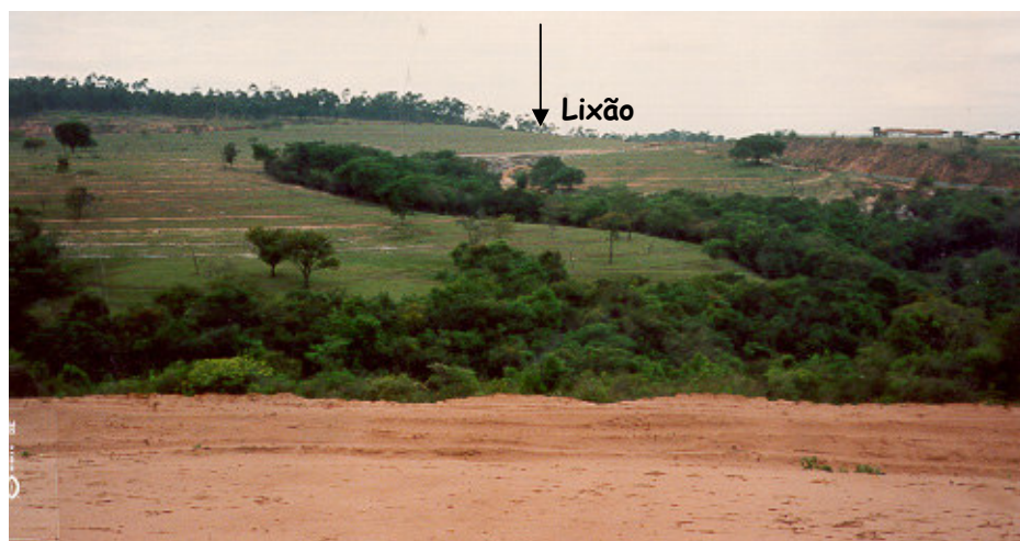
Figura 5.30: observa-se a utilização de lixo como aterro na área da fazenda em 1992.
