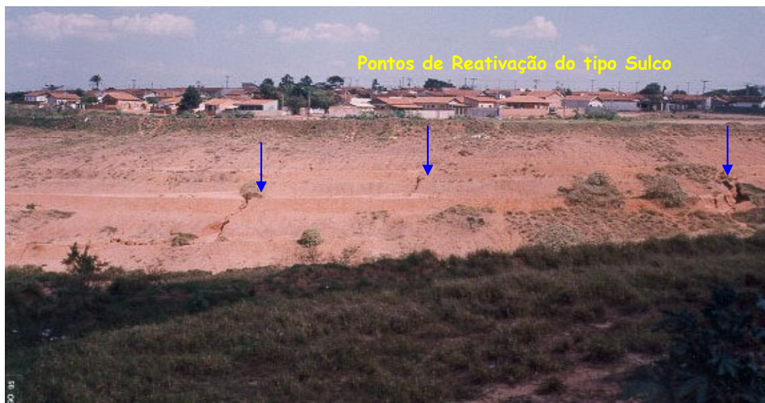
Figura 5.2- Encosta direita do Dimas, observar os cordões de nível e as reativações do tipo sulcos em alguns pontos. As setas mostram pontos de reativação.
