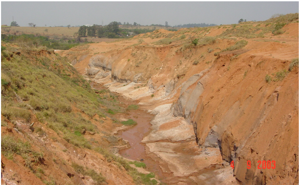
Figura 2.4: Voçoroca localizada no município de São Pedro (SP)
