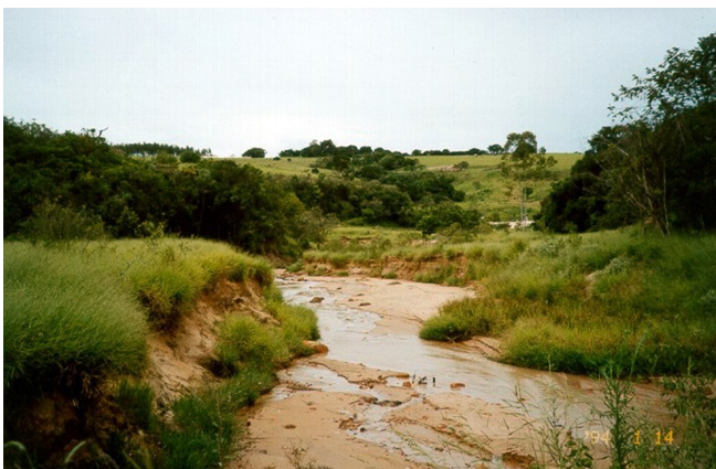
Figura 15 - Erosão marginal do córrego do Espraiado e seu assoreamento.
