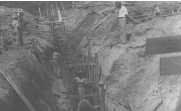
Figura 7 - Instalação de rede de esgoto para a futura Estância, em 1941 (Foto Arquivo Moura Andrade)
