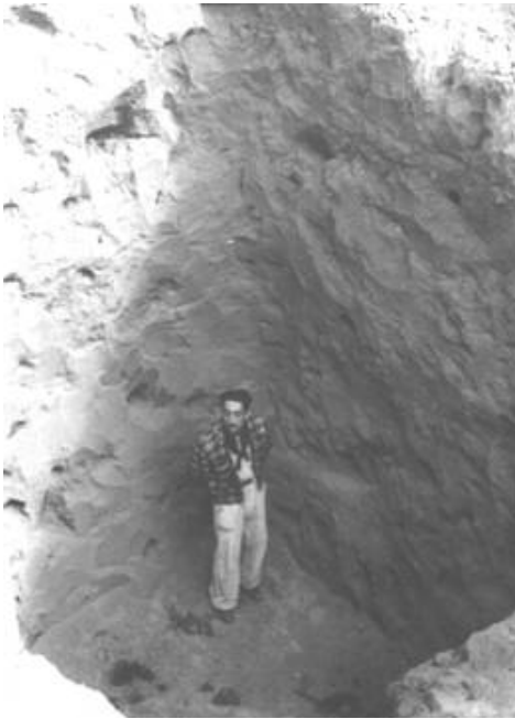
Figura 10 - Covas de 2 x 2 m de diâmetro e 3,5 m de profundidade para a substituição da terra local por terra fértil, em 1941 (Foto Arquivo Moura Andrade)
