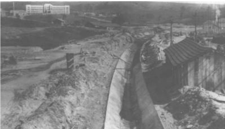
Figura 9 – Realização das obras do canal principal da futura Estância, realizada em 1940 (Foto Arquivo Moura Andrade)
