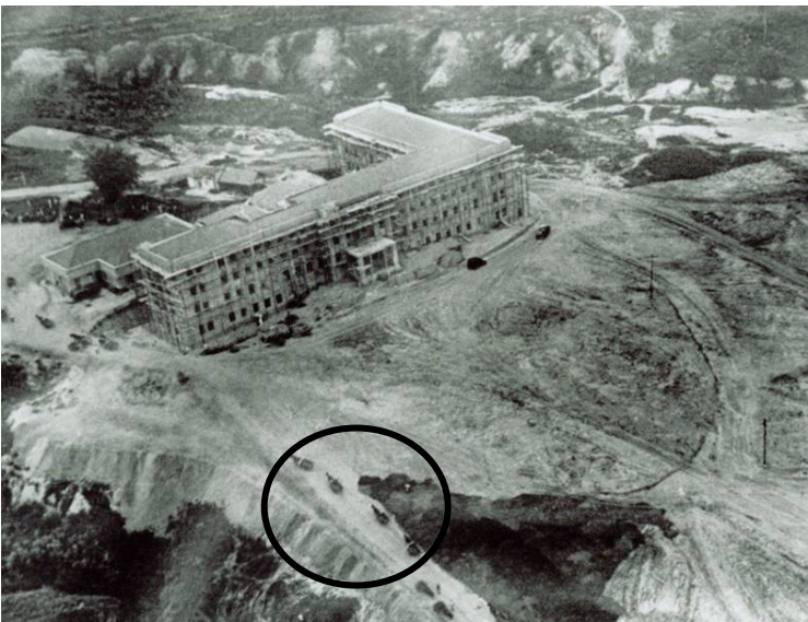
Figura 5 - Vista aérea das obras do Grande Hotel São Pedro, em 1939, com destaque às carroças de tração animal, fazendo o aterro do atual gramado (Foto Arquivo Moura Andrade)
