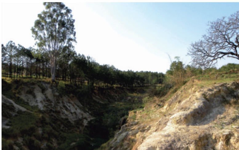
Figura 9 - Feição erosiva com taludes acentuados e profundos. No seu interior, verifica-se a presença significativa de solo exposto e de graus demonstrando ainda sua evolução. Ano 2013.
