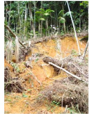
Figura 3: Detalhe do trecho da trilha onde ocorreu o escorregamento de terra da margem.
