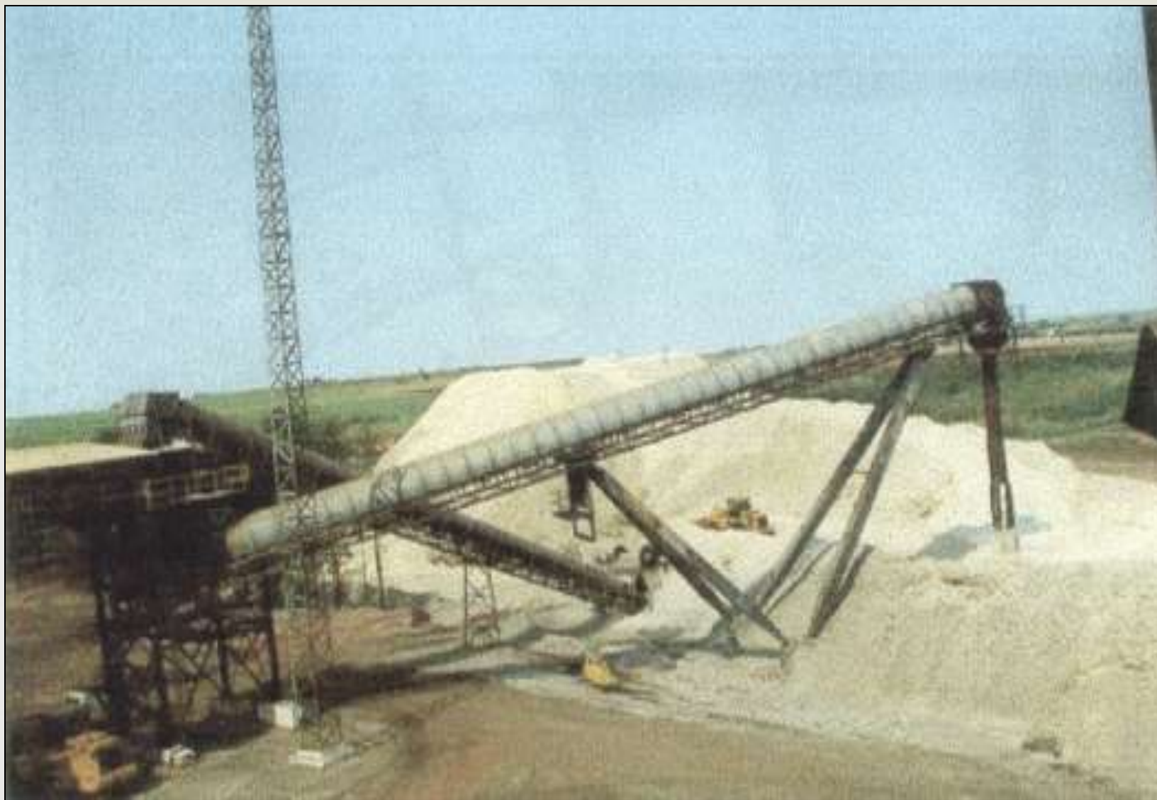
Vista do Sistema de bagaço
