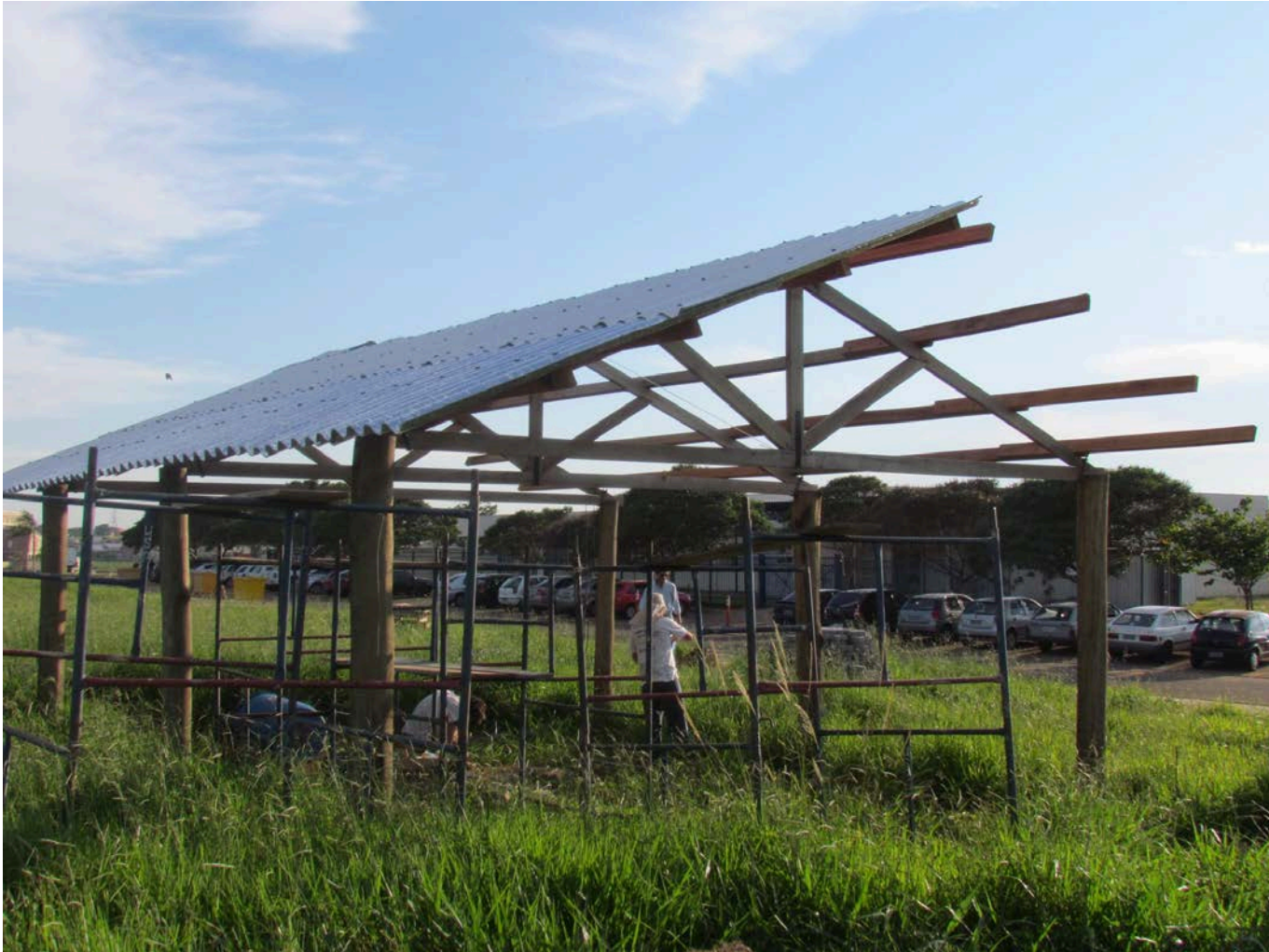
Construção do pátio de compostagem no campus II
