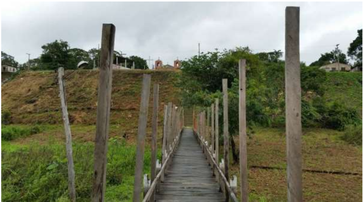
Figura 3: Passarela que dá acesso às escadas de Cameté do Ramos
