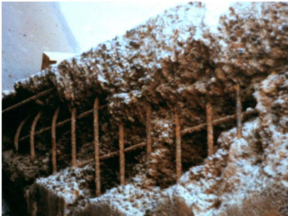
*Figura 6.30 Vista da erosão na lateral em um dos blocos de queda.*
