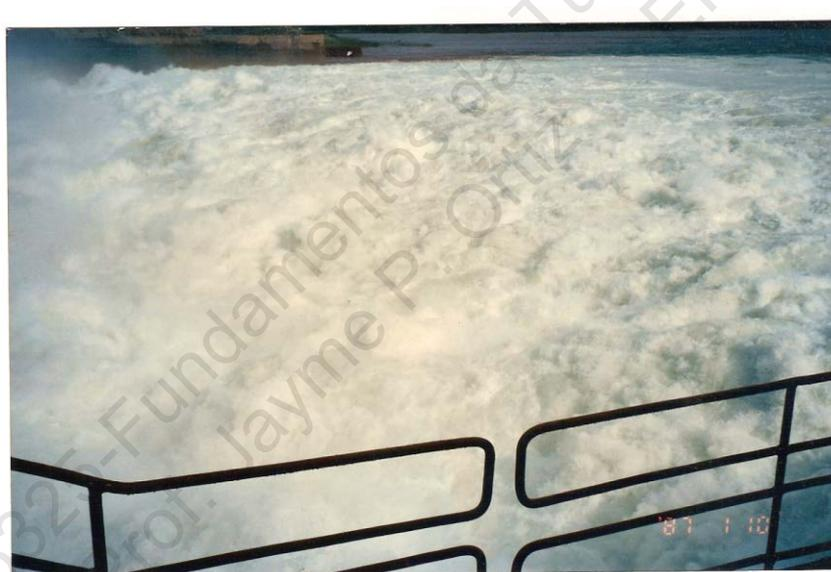
Figura 6.2 Ressonho hidráulico na bacia de dissipação da U.H. Porto Colômbia
