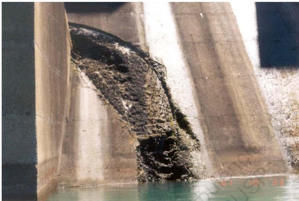
*Figura 6.19 Vista da erosão no vertedor na região lateral do bloco – UHE Ilha Solteira (CD –acervo biblioteca CTH).*
