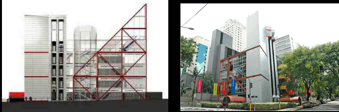
Pórtico treliçado e estaiado: Escola Panamericana de Arte, Ziegbert Zanettini, 1999
