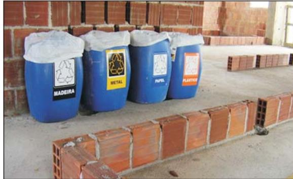
**Figura 10:** Exemplo de equipamentos simples de acondicionamento segregado de resíduos classe B, dispostos nos próximos aos pontos de geração.
