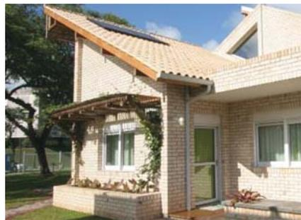
**Figura 4:** Proteção por meio de pergolado com vegetação na parede leste. Projeto Casa Eficiente. Florianópolis (CASA EFICIENTE)
