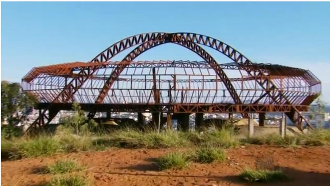
Imagem 2.2.1 - Vista do sistema estrutural do edifício, em sua maior parte composto por elementos pré-fabricados de aço.
