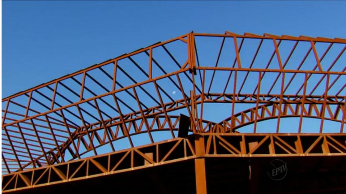
Imagem 2.2.3 - Vista, a partir do nível térreo, dos elementos metálicos que circundam o piso superior formando um gradil. Conforme denominação apresentada nas instruções do exercício, esses elementos serão identificados pelo título de “paredes laterais”. (Fonte: <<http://globo.com/rede-globo/mgtv-1a-edicao/v/obras-do-memorial-do-et-de-varginha-devem-ser-retomadas/2757726/>>).
