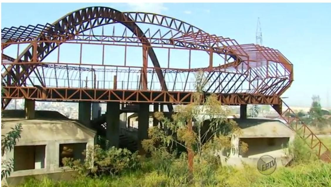
**Imagem 2.2.2 - Como é possível ver na fotografia, a caixa de circulação sustenta o piso superior em sua porção central, enquanto que as bordas externas do piso se encontram apoiadas nos arcos treliçados**
