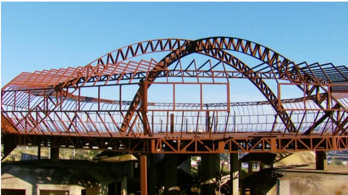
Imagem 2.2.4 - Vista do conjunto de paredes laterais, apoiadas sobre a borda externa do piso superior. (Fonte: <<http://globo.com/rede-globo/mgtv-1a-edicao/v/obras-do-memorial-do-et-de-varginha-devem-ser-retomadas/2757726/>>).
