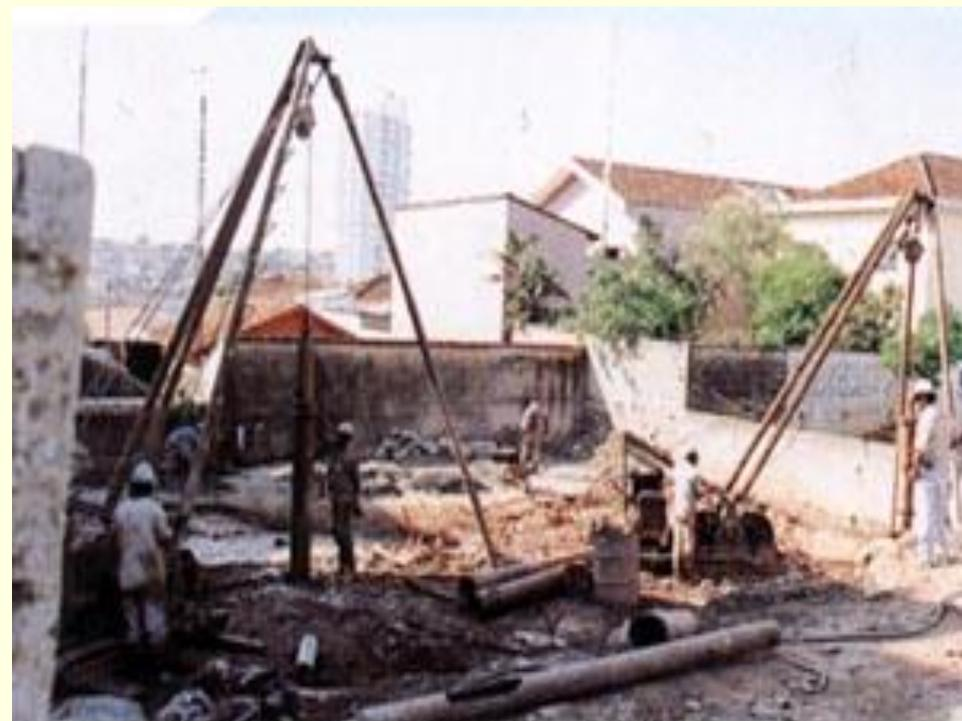
**Máquina para execução de estaca "Strauss"**
