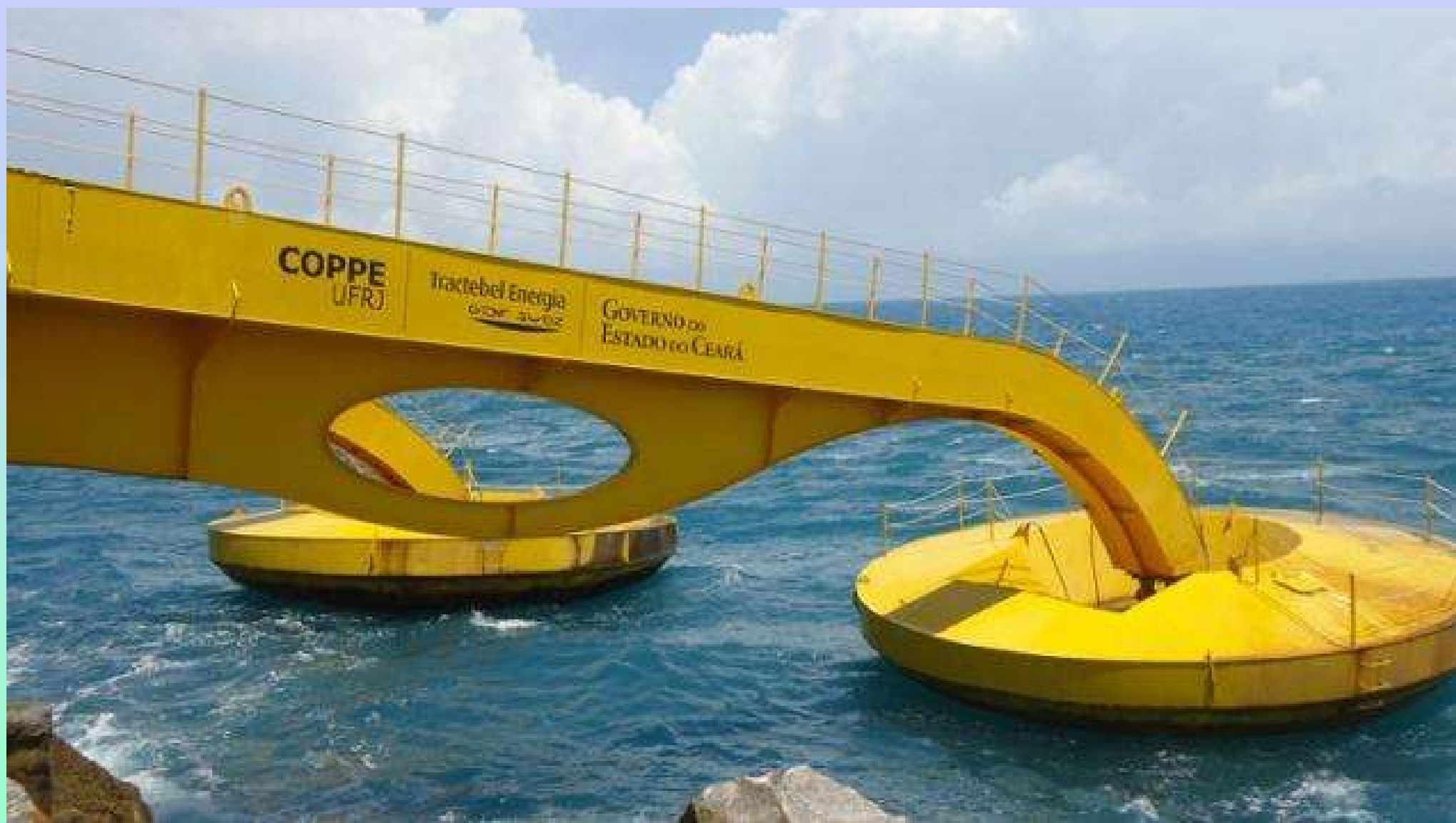
Usina piloto do Porto de Pecém, Fortaleza (CE).
