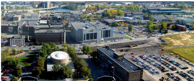
ÉTS - Fase 1 - Prédio A
