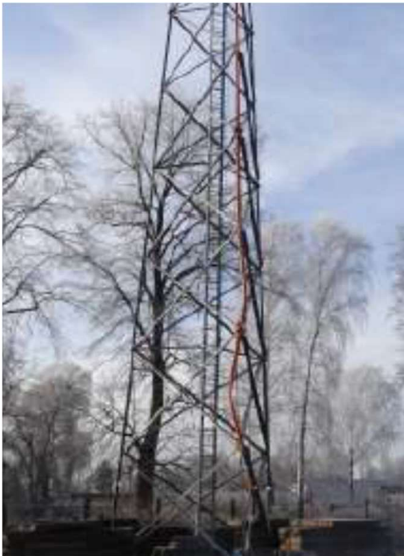
Fig.3: Instabilidade estrutural em barras de uma torre treliçada [3]
