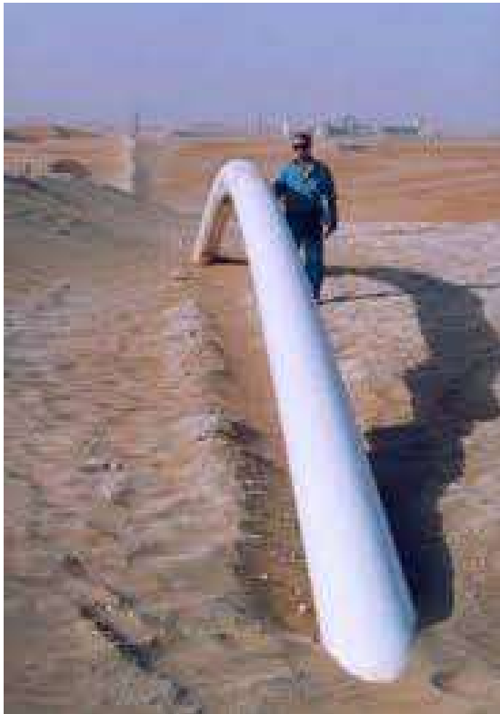
Fig.6: Instabilidade estrutural de dutos (pipeline upheaval buckling, pipeline lateral buckling) [7].
