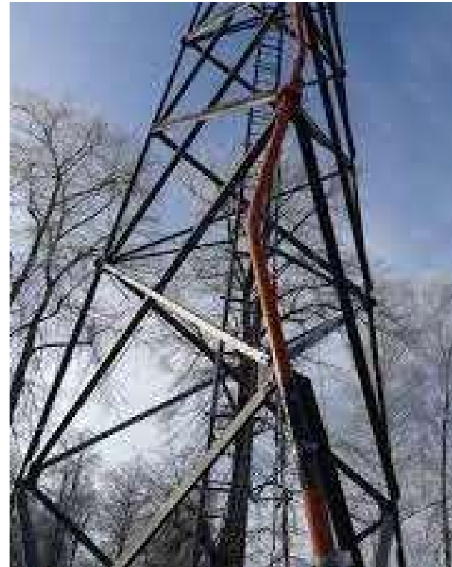
Fig.3: Instabilidade estrutural em barras de uma torre treliçada [3]
