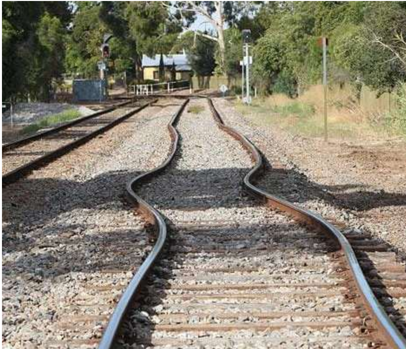
Fig.5: Instabilidade de trilhos de trem ( railway track buckling ) [5,6]
