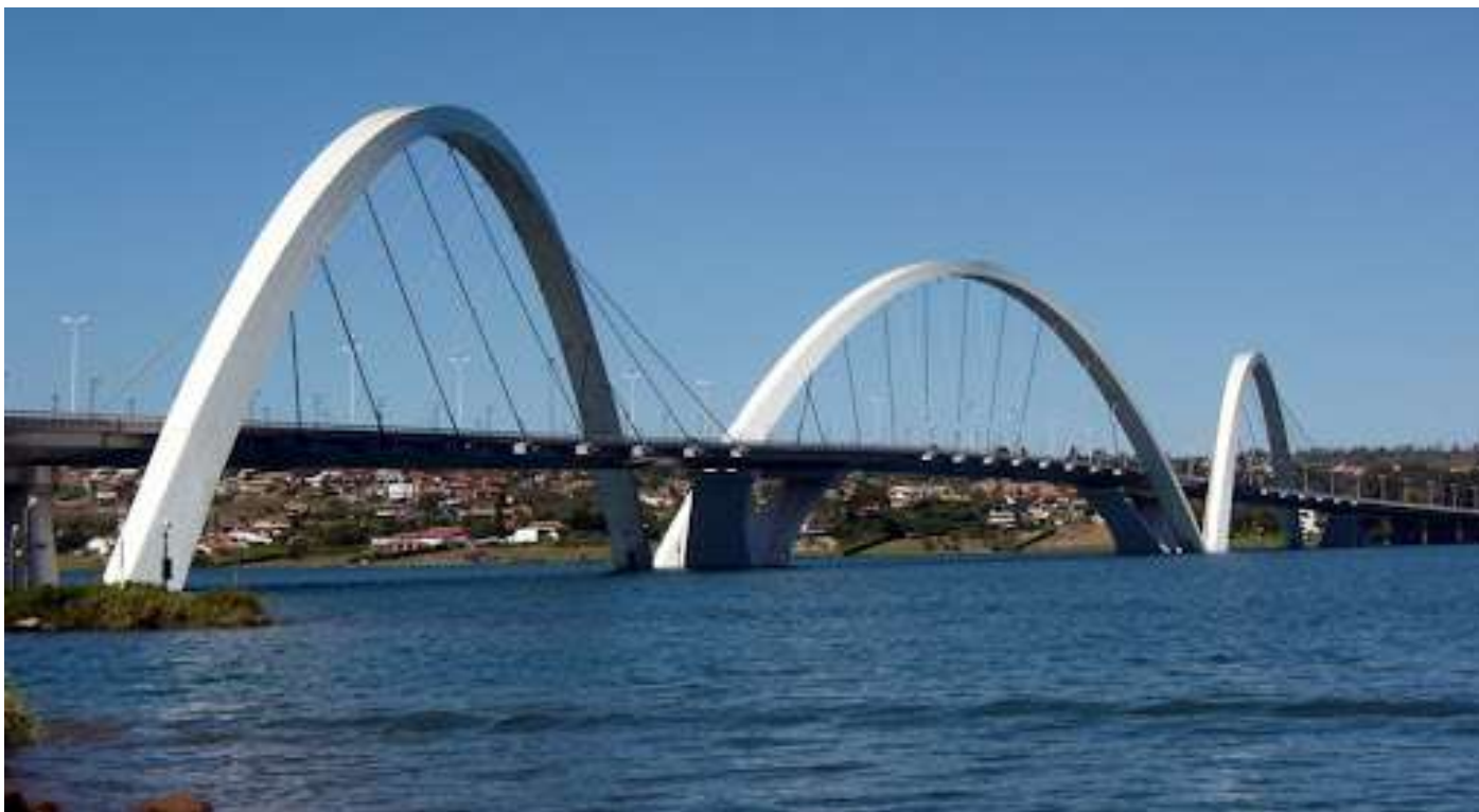
Fig. 4. Arcos sustentando a ponte Juscelino Kubitschek, em Brasília [1].
