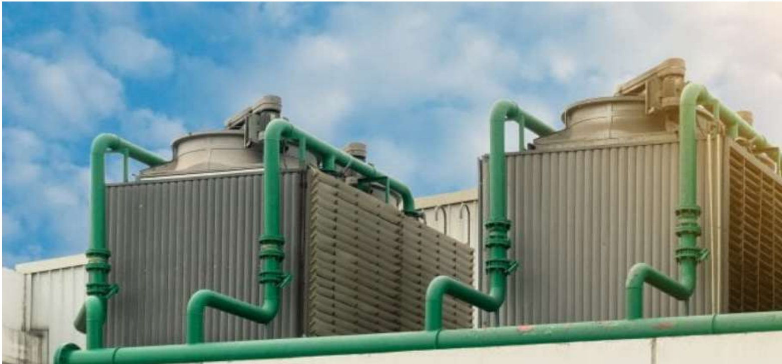
Fig. 2. Outros exemplos de tubulações industriais que podem ser analisadas como estruturas reticuladas.
