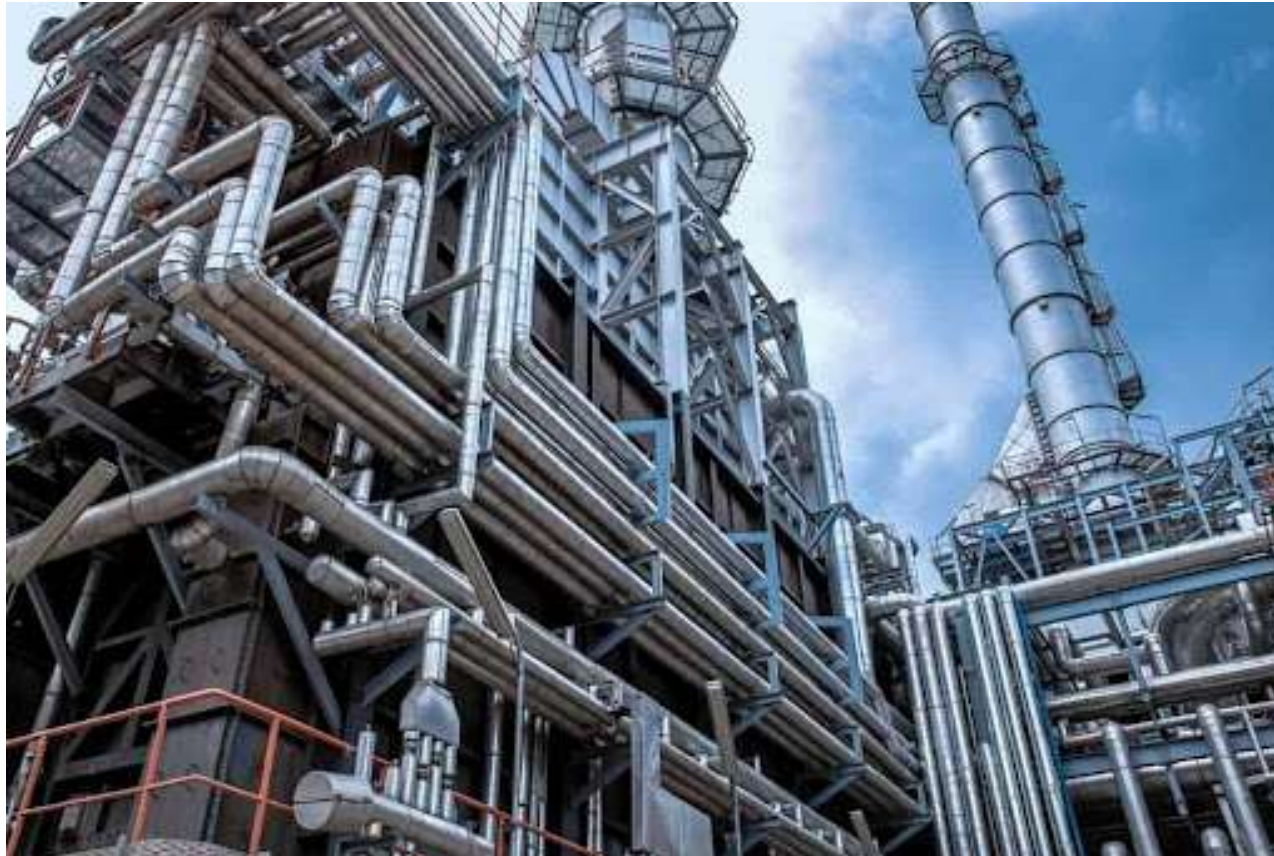
Fig. 1. Tubulações industriais são exemplos típicos de estruturas reticuladas.
