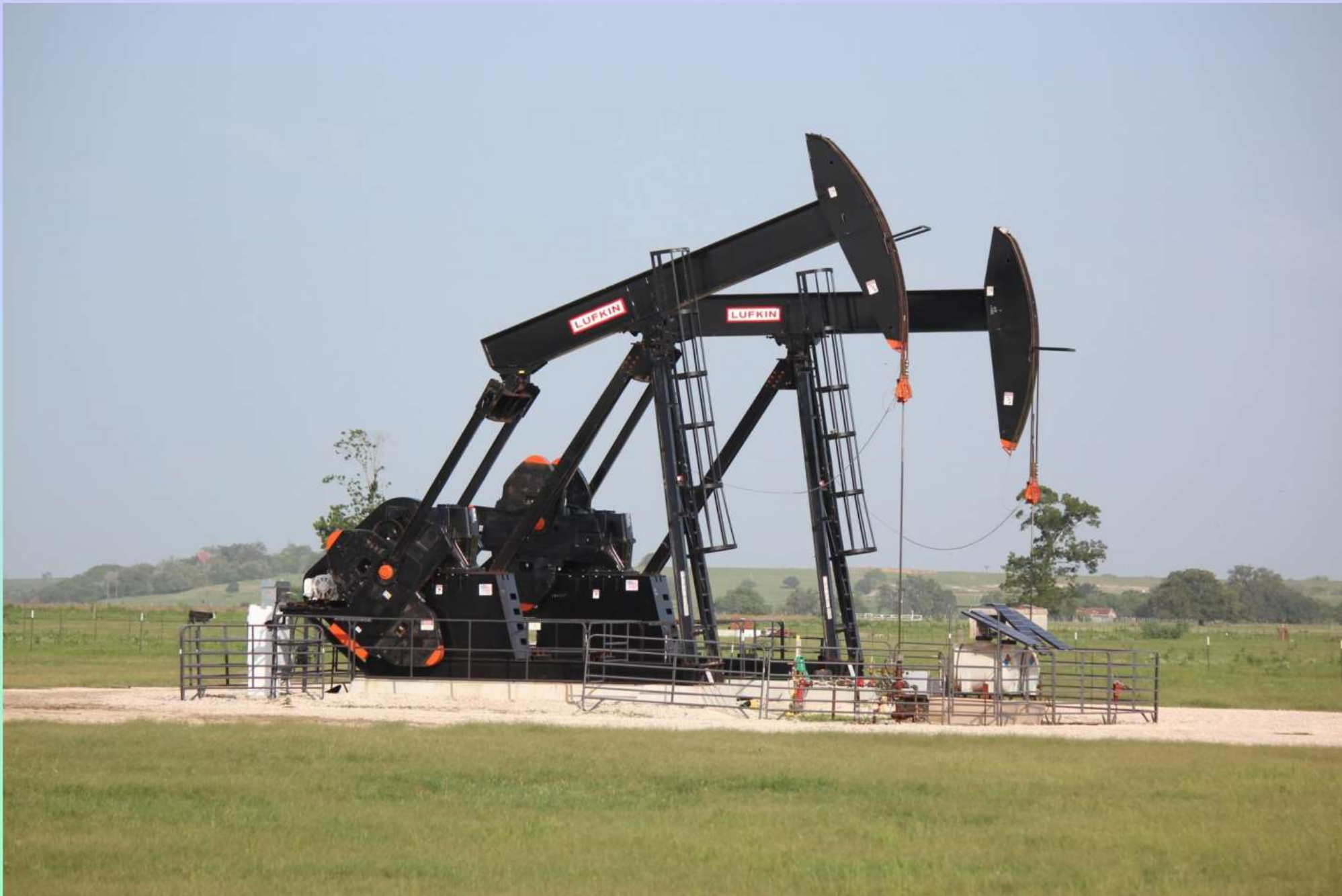
Poços de Petróleo em atividade – Kenedy-Texas
