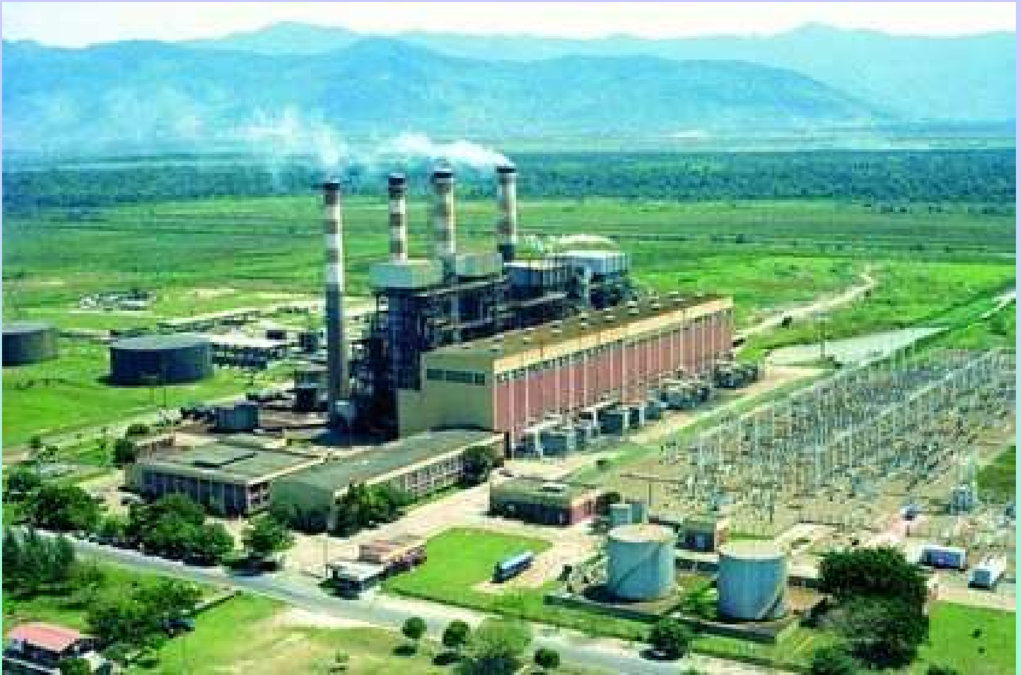
USINA TERMELÉTRICA DE SANTA CRUZ (RJ) – 775 MW (imagem de 1973) Atualmente possui 2 turbinas à gás natural de 175 MW cada)
