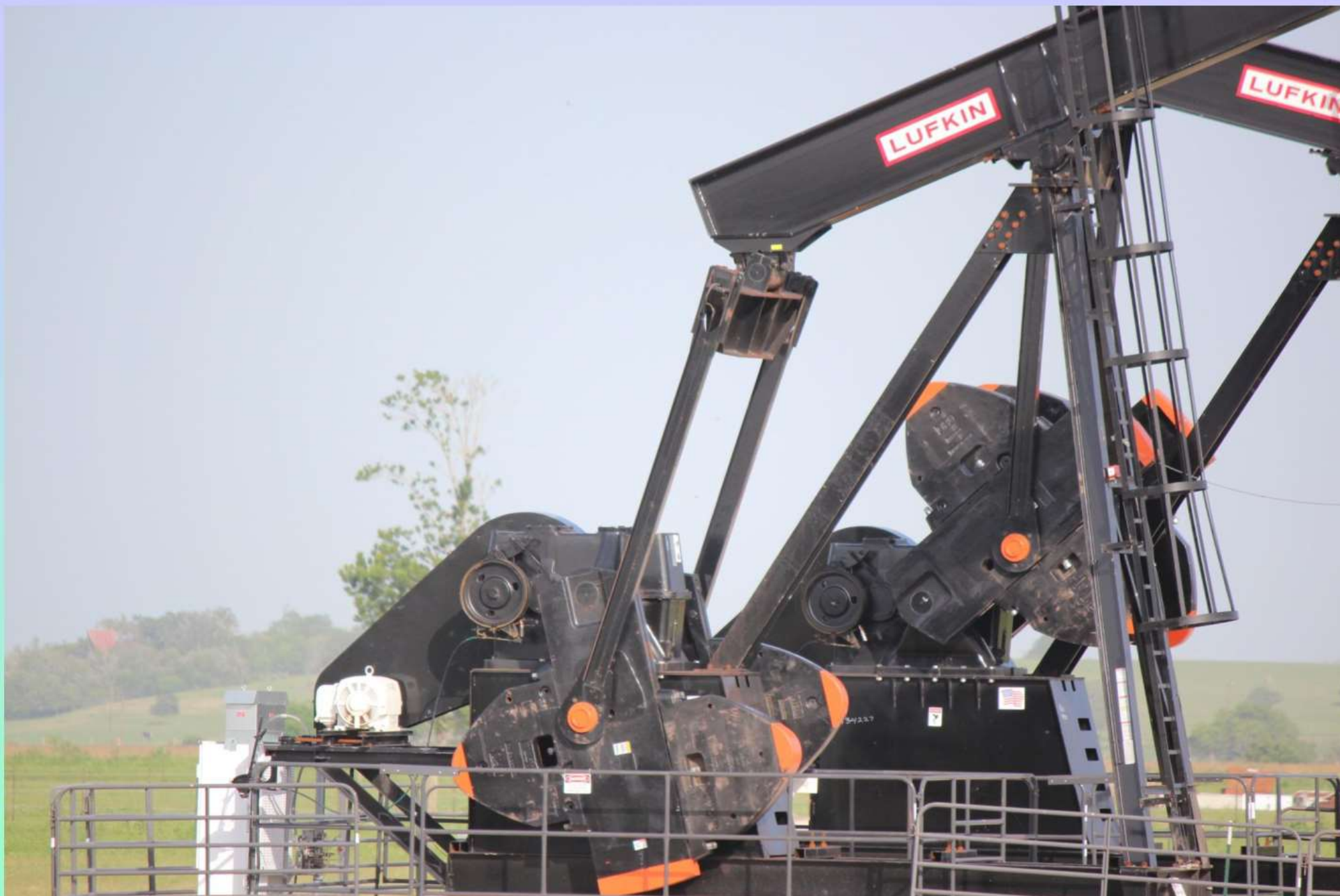
Poços de Petróleo em atividade – Kenedy-Texas
