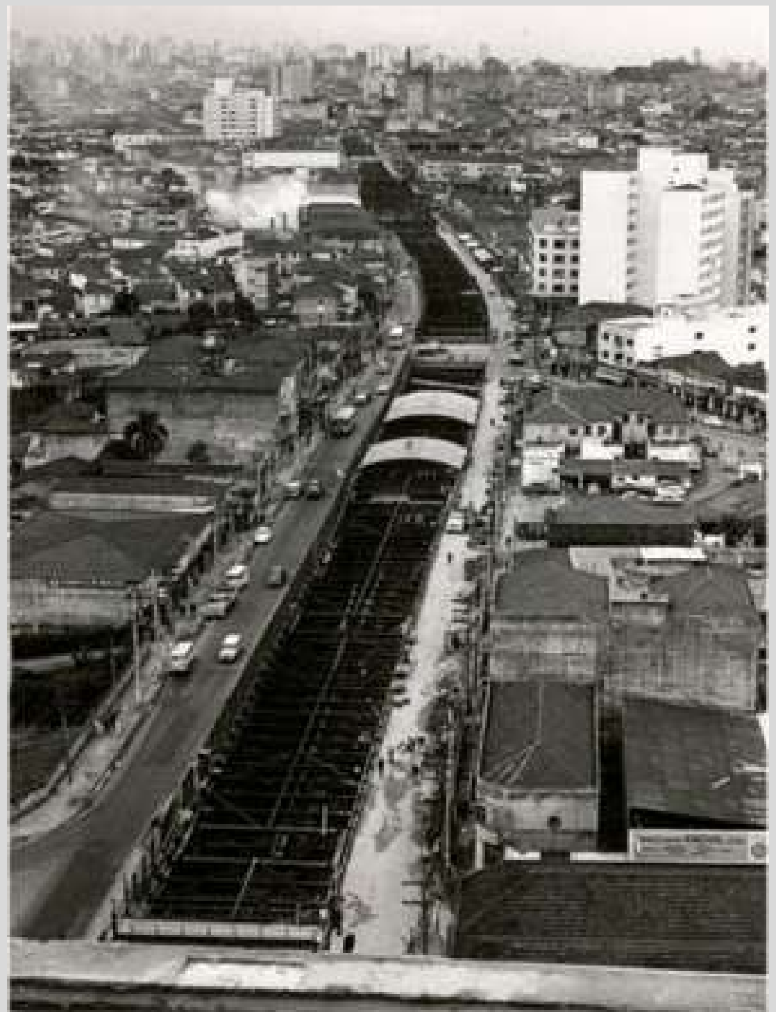
Construção da Linha 1 – Azul na década de 70
