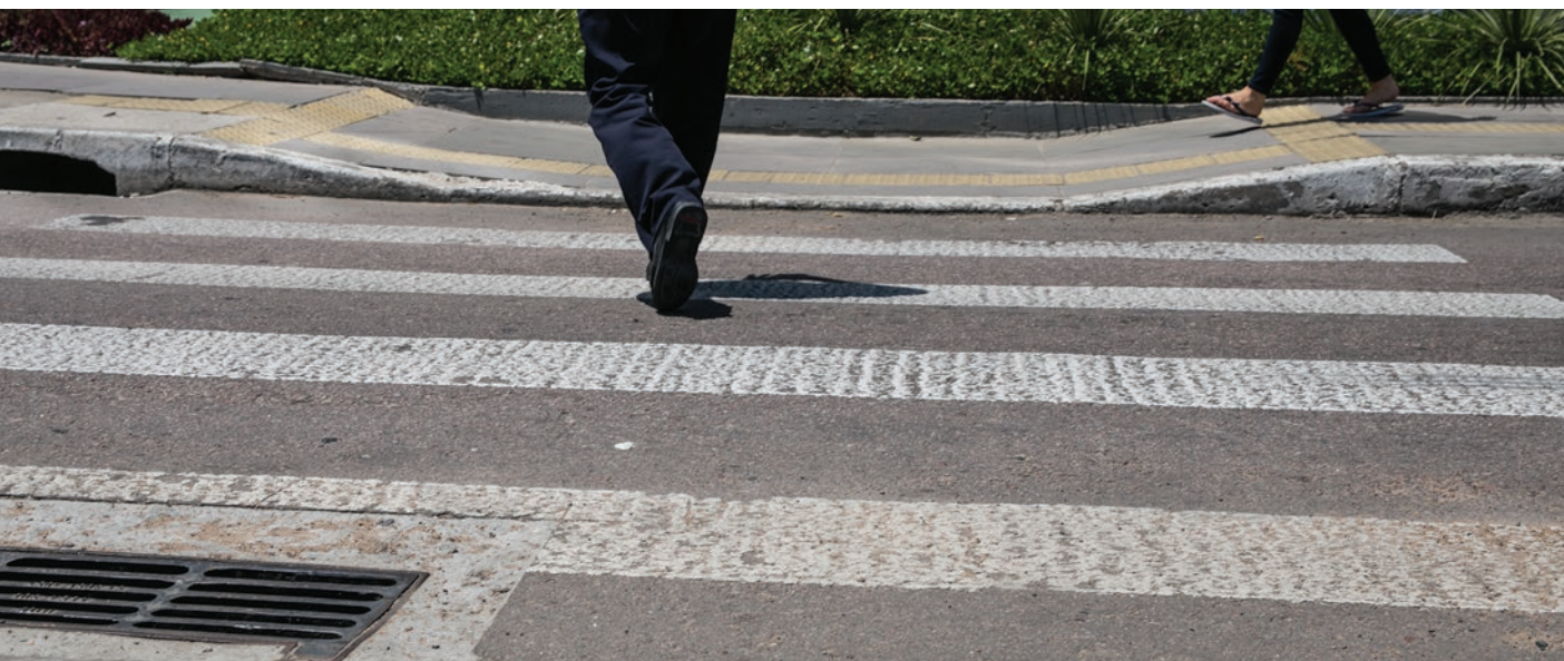
Figura 2.1.3 | Rebaixamento paralelo ao meio-fio
