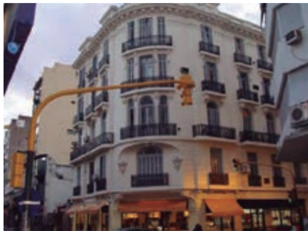
Edificio patrimonial. Alsina 1599
