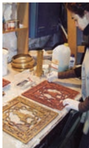
Decapado y limpieza de metales
