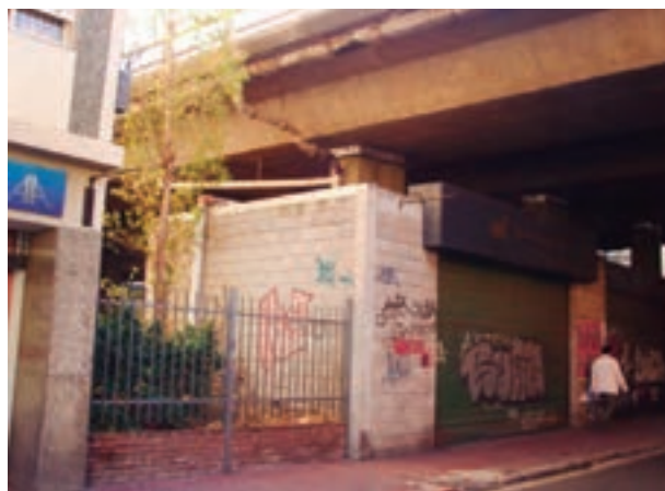
Estado actual de borde y bajo autopista
