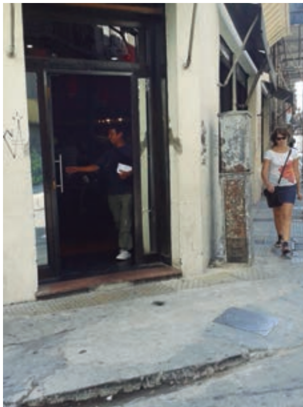
Calle Rivadavia al 600. Estado actual
