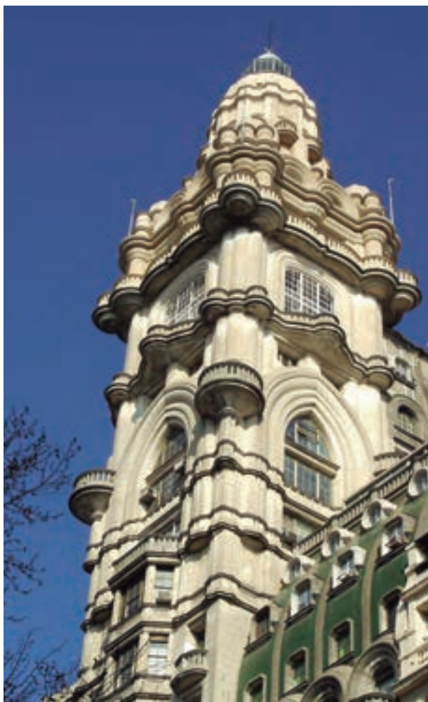
Palacio Barolo. Avenida de Mayo 1370
