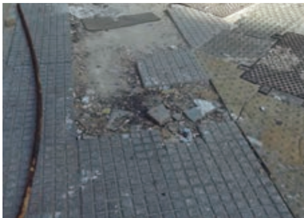
Calle Rivadavia al 600. Estado actual
