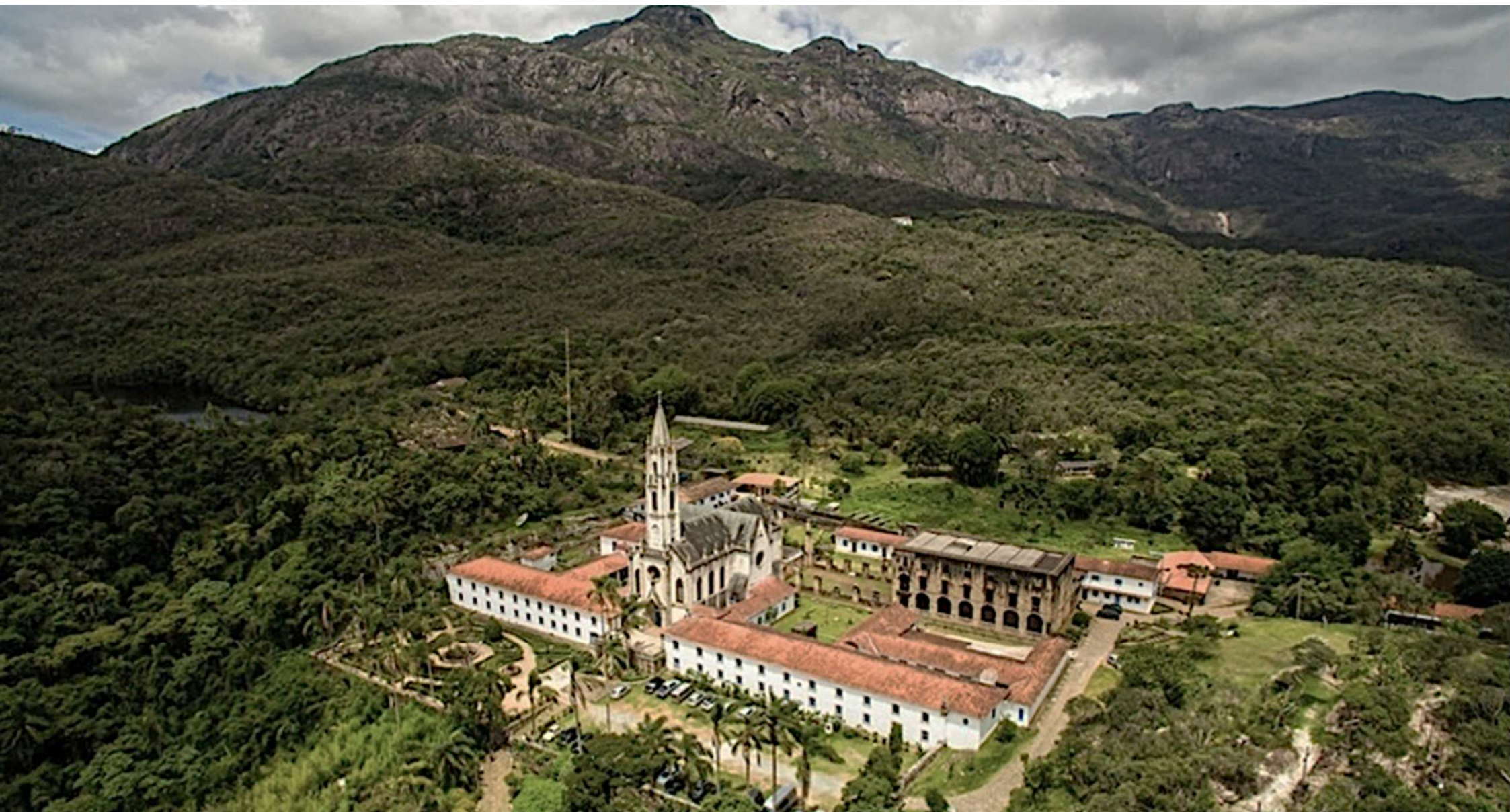
INTERVENÇÃO EM RUÍNAS | SANTUÁRIO DO CARAÇA, MINAS GERAIS
