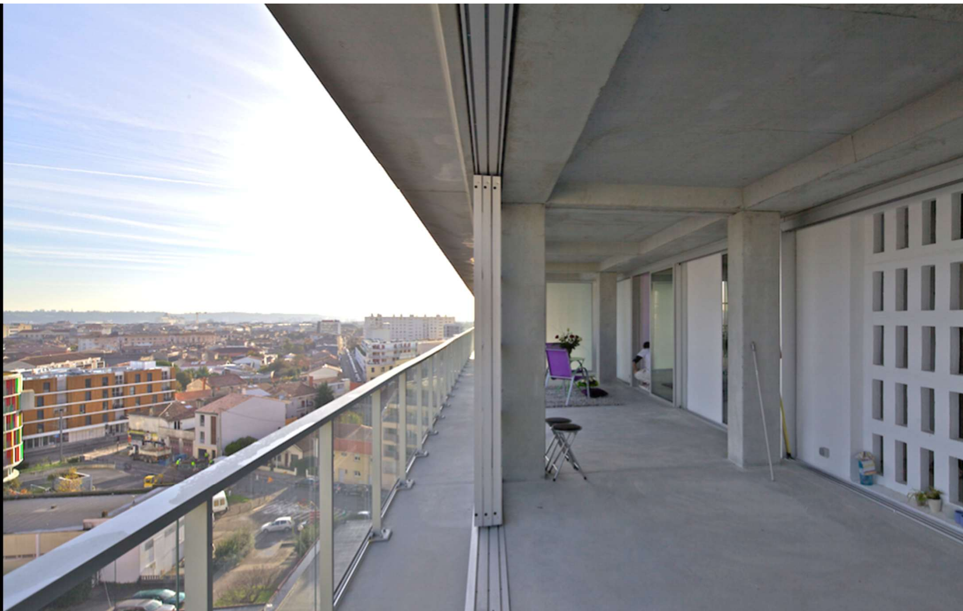
AMPLIAÇÃO, REABILITAÇÃO | HABITAÇÃO SOCIAL, BORDEAUX, LACATON ET VASSAL, 2017
