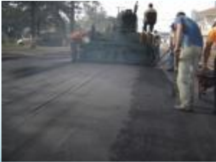
Processo de impermeabilização do solo
