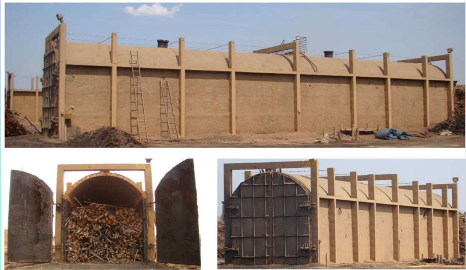
Figura 3.1 – Forno típico de Alvenaria modelo RAC220.
