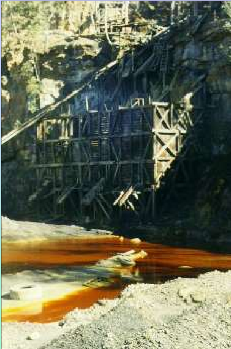
Mina de carvão abandonada- Criciúma/SC
