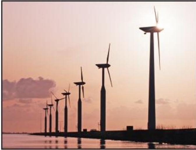
Turbinas de vento
