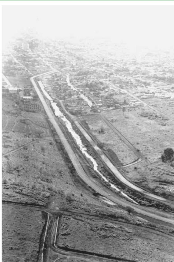
Construção da Avenida Marginal em 1974 na região do Córrego do Gregório, nas proximidades da área onde atualmente se localiza o SESC.
