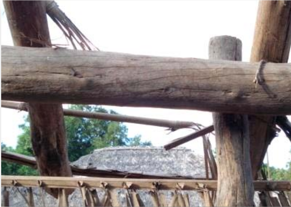
Fig. 105. Vigas de hadena , “cega-machado”, usada pelos Karajá na construção de suas casas. Aldeia de Santa Isabel do Morro, julho de 2008.
