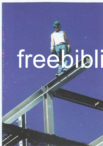
Figura 12-3 Um operário de pé em uma viga está em equilíbrio estático, mas sua posição é mais estável na direção paralela à viga que na direção perpendicular. (Robert Brenner/PhotoEdit)
