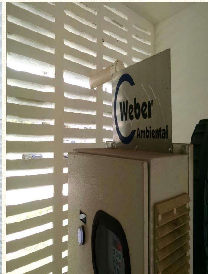
Abrigo com exaustão direcionada para o elemento vazado.
