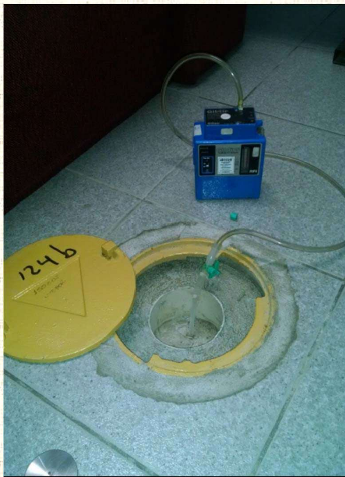
Poço de monitoramento de gás PMG-124 B, localizado no Transporte. Procedimento de purga antes da amostragem.
