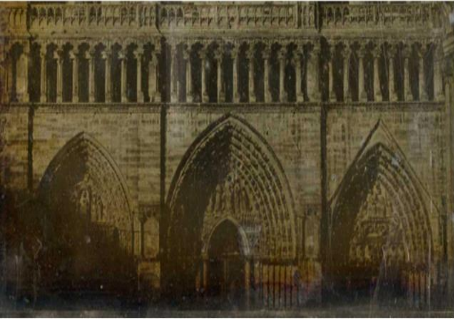
Fachada occidental antes de 1843, BNF.
