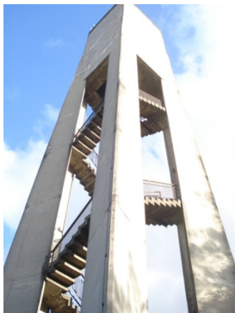
Figura 70: A torre do lado de fora do prédio: em seu topo, está a caixa d'água.
