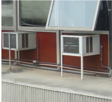
Figura 34: Aparelhos na parte externa do prédio
