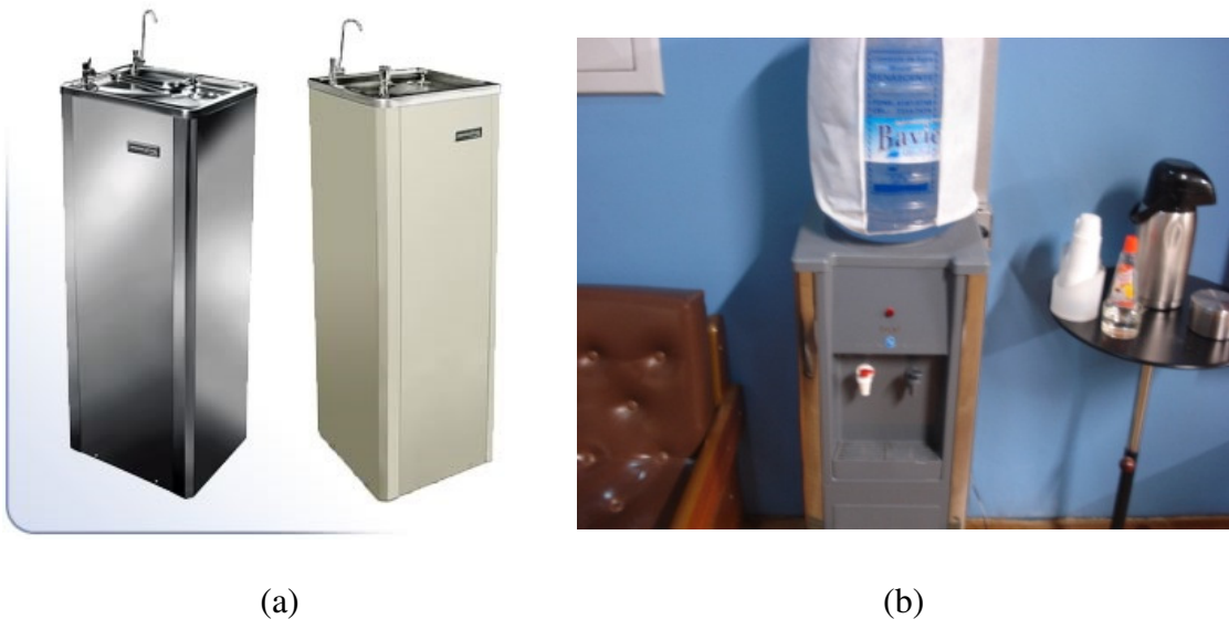
Figura 27: os dois tipos bebedouros encontrados no prédio: o de bocais (a) e o de galão, torneiras e copos (b).
