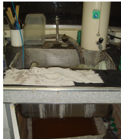
Figura 52: Pia sob a qual há um tanque para fazer decantação
