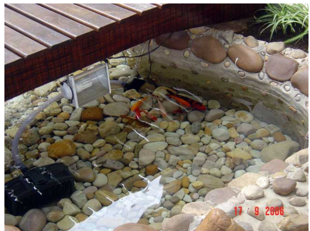
Figura 9: lago depois da instalação do filtro UV
