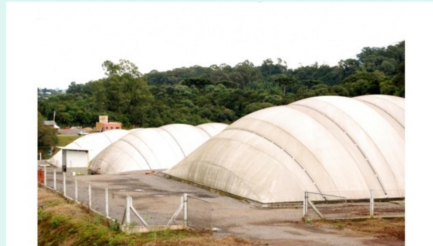
Em Carlos Barbosa/RS, o sistema de biodigestores é composto por três cúpulas (balões) com espaço para 1,5 milhão de litros de dejetos, totalizando 4,5 milhões de litros. O sistema recebe em média 60 mil litros/dia de dejetos vindos da suinocultura e pode produzir aproximadamente 1000 m<sup>3</sup>/dia de **biogás**.
