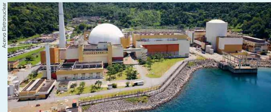
O edifício do reator, construído em concreto e envolvendo a contenção de aço, é a quarta barreira que serve para impedir a saída de material radioativo para o meio ambiente e, além disso, protege contra impactos externos (queda de aviões e explosões). Vemos na fotografia os edifícios dos reatores de Angra II à esquerda e Angra I à direita. Fotografia de 2014.
