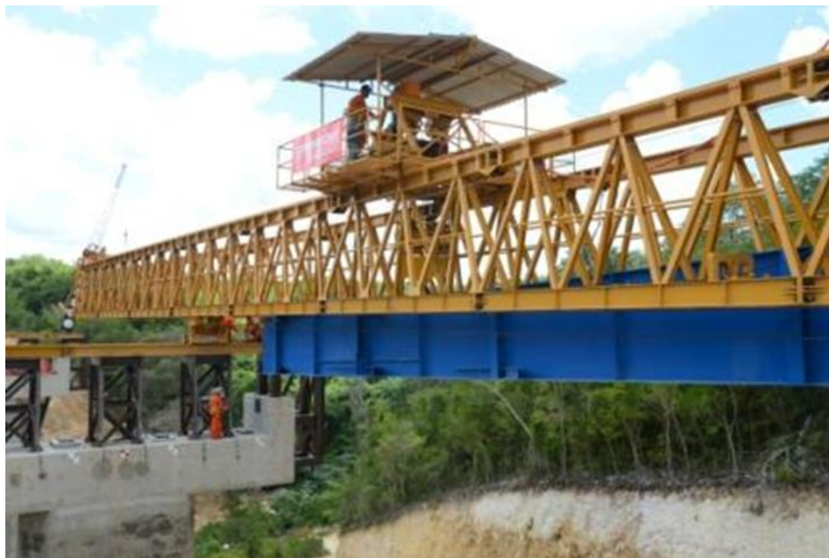
Figura 53 – Vista lateral durante o lançamento
