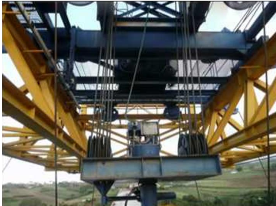
Figura 54 – Vista inferior do conjunto da treliça
