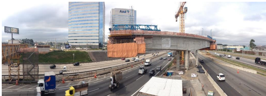
Figura 63 – Obra curva em execução, observar o desequilíbrio dos pilares.
