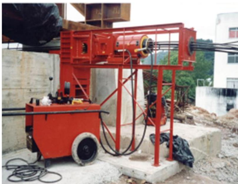
Figura 73 – Lançamentos progressivos – Sistema de tração na ponte do Tamarindo, em Blumenau.
