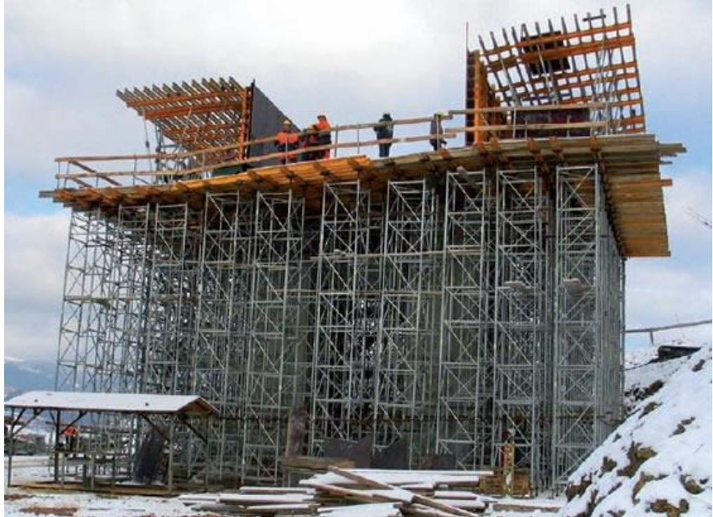
Figura 51 – Escoramento tubular
