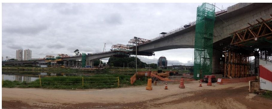
Figura 64 – Obra próxima do fechamento, observar o nivelamento dos lados.
