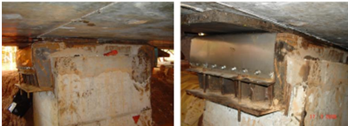
Figura 72 – Ponte Gênesis II – “Telefone” sobre o apoio provisório.
