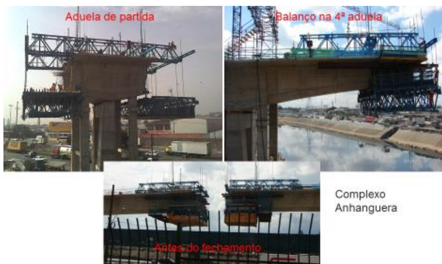
Figura 62 – Fases do método construtivo
