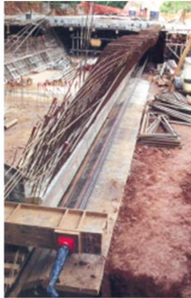
Figura 74 – Lançamentos progressivos – Ancoragem do sistema de tração.
