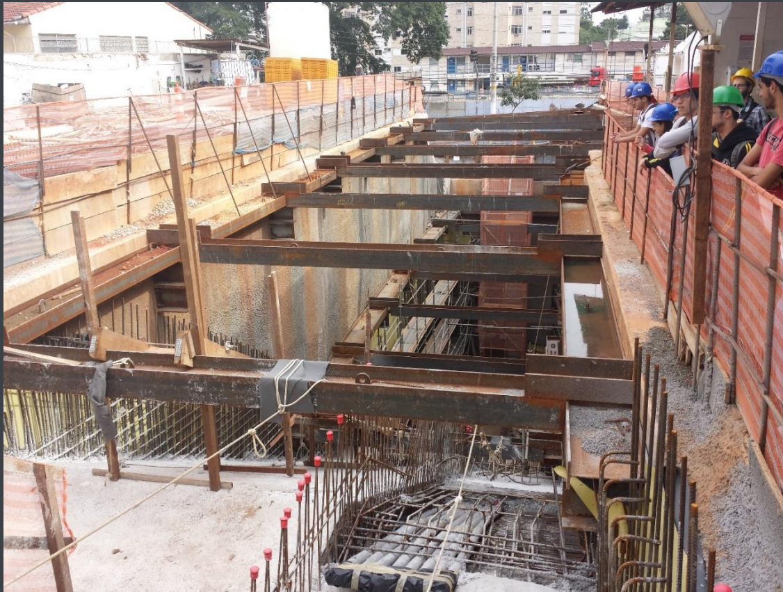
Obras de escavação da estação Santo Amaro do Metrô
