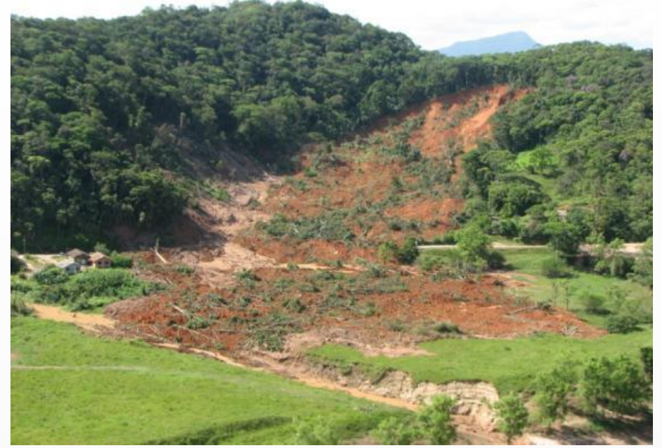
Dois deslizamentos. O segundo com vítimas
