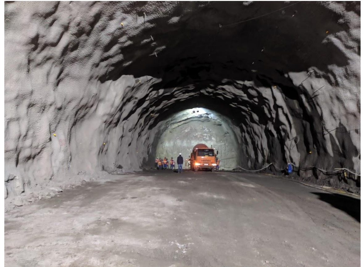
Foto tirada durante visita à obra de um dos túneis em 20/11/2019
