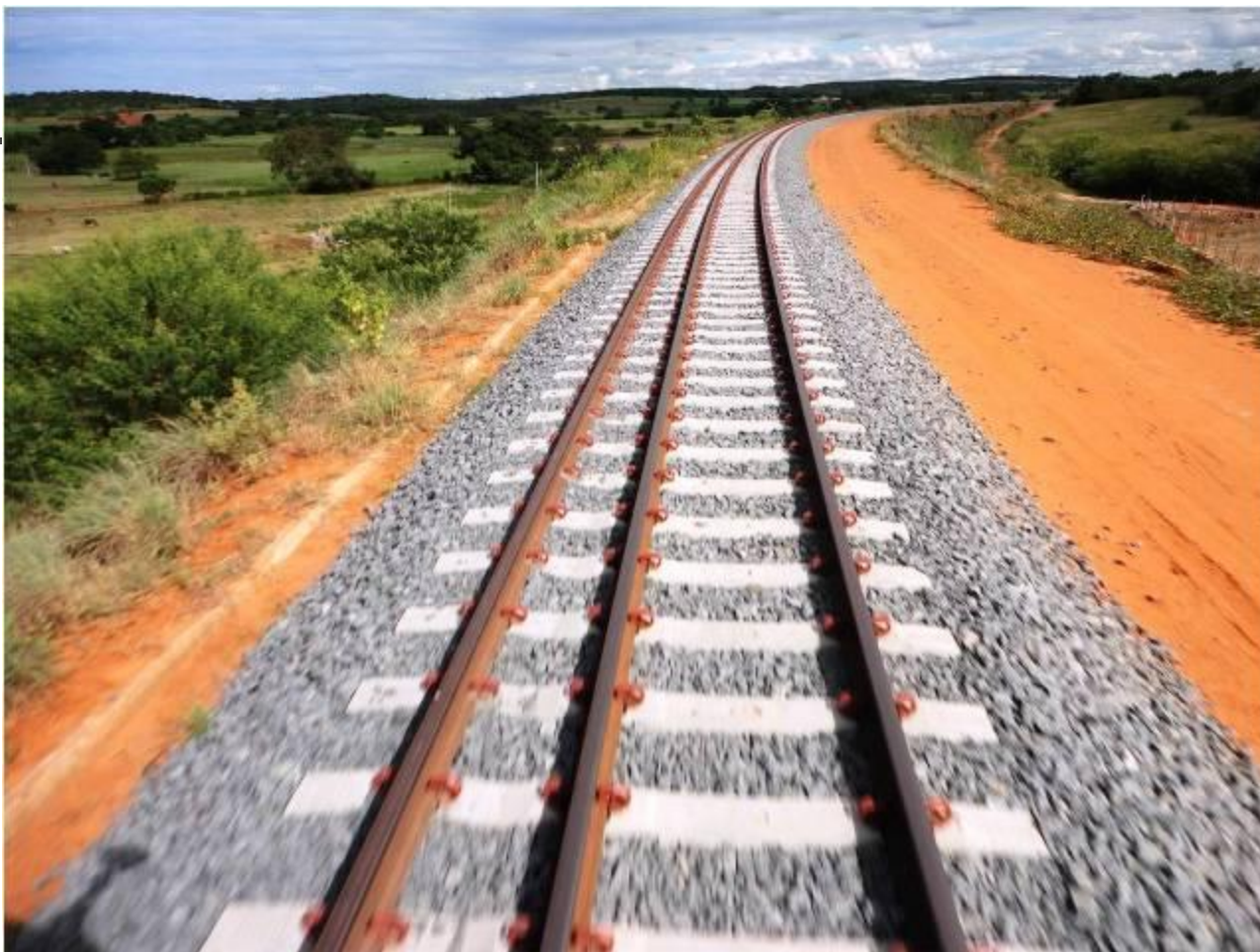
Ferrovias Transnordestina: Alça de bitola mista segue com destino ao CE, alça em bitola larga segue ao litoral de PE
