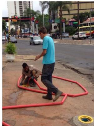
\* Injeção de inóculo enriquecido em poços de injeção (Processo BiogeoTec/Microbiol)
